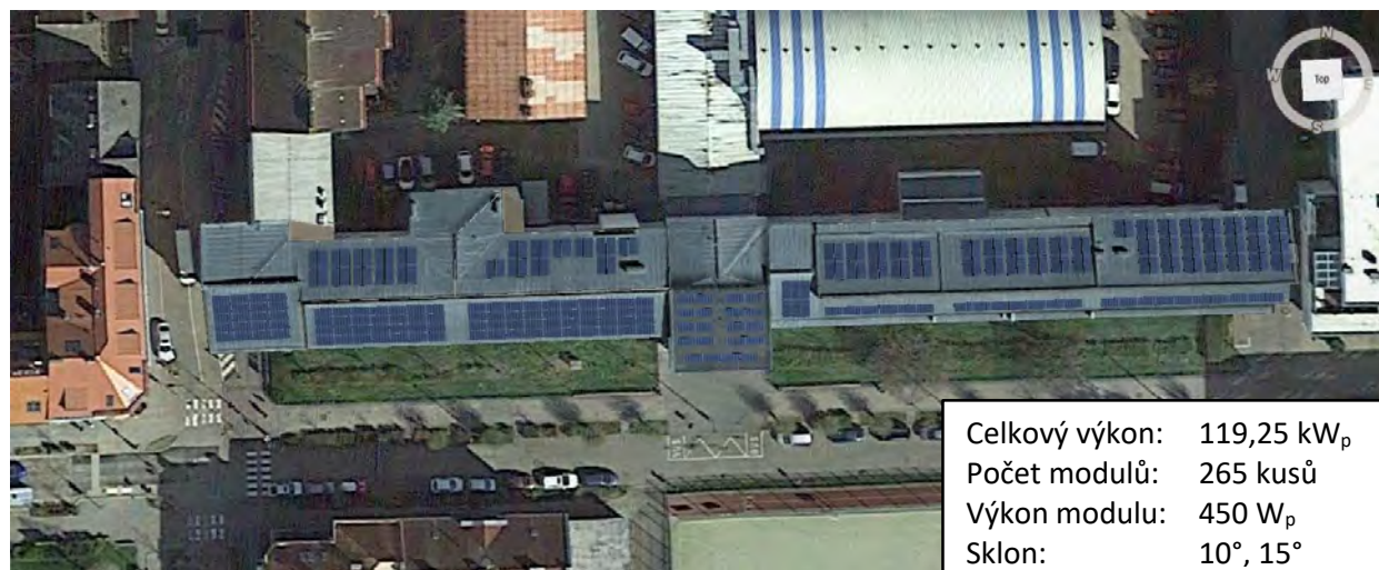
Obrázek 2 Umístění FVE na budově
