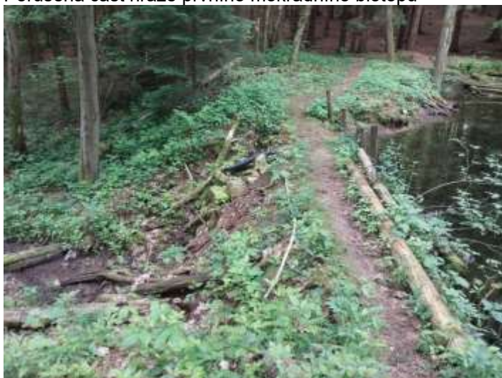
Porušená část hráze prvního mokřadního biotopu
