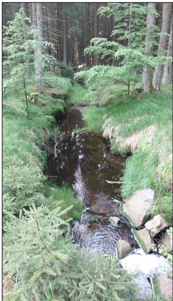
Trubní propust vodního toku Hlučál pod lesní cestou
