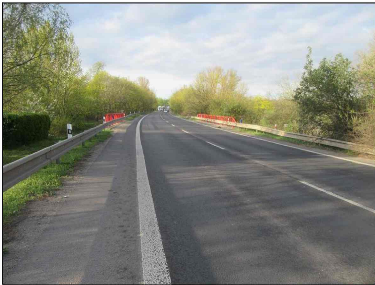
Pohled na most po směru staničení.
