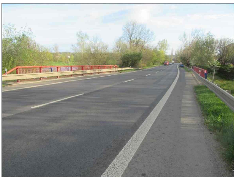
Pohled na most proti směru staničení.
