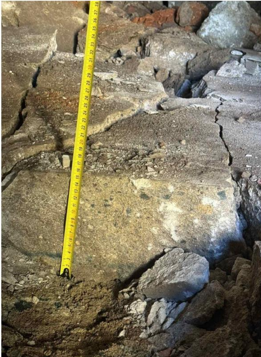
ZL č. 15 – SO 01 Změna skladby m.č. 0.17_bourání
