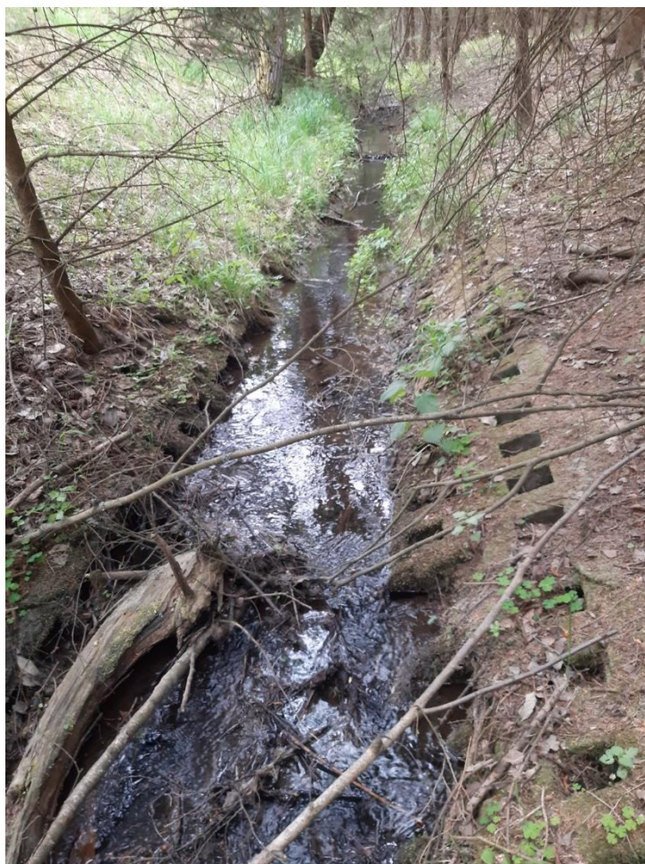
Obr. č. 4 a 5) Zatravnovací betonové panely opevňující dno i břehy VT v celé délce
