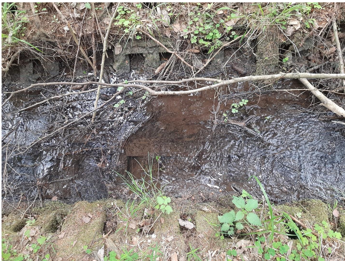
Obr. č. 4 a 5) Zatravnovací betonové panely opevňující dno i břehy VT v celé délce
