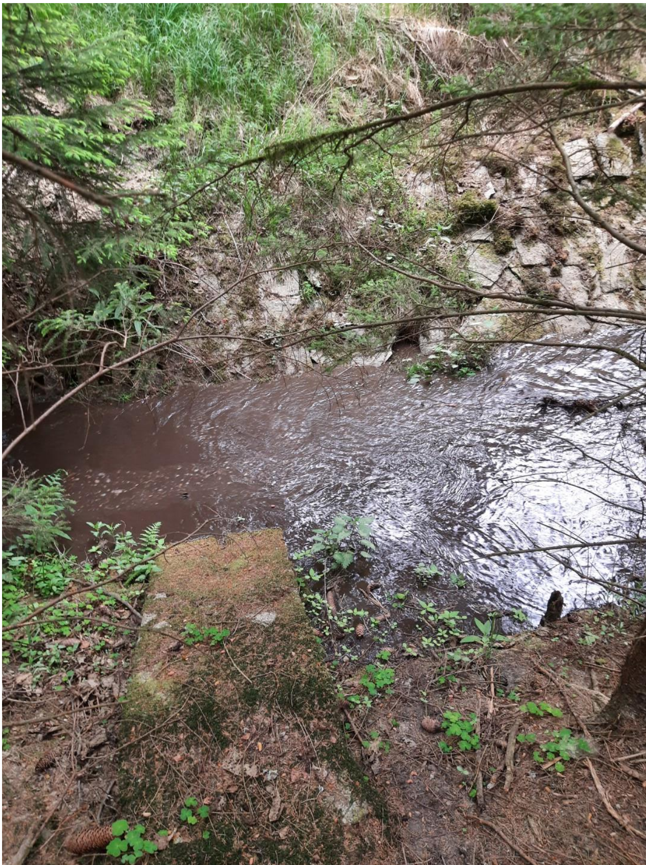
Obr. č. 6) Jeden z betonových prahů s kamennou dlažbou
