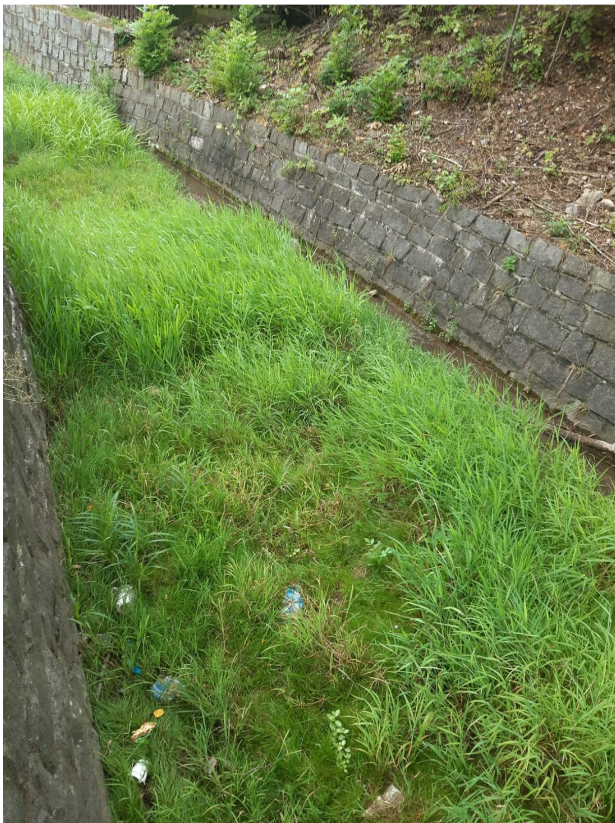
Foto č. 9 – Koncový úsek úpravy
