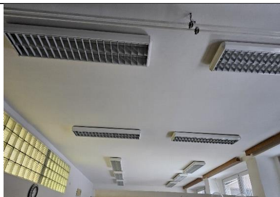
Obrázek 31: Kmenová učebna – původní osvětlení
