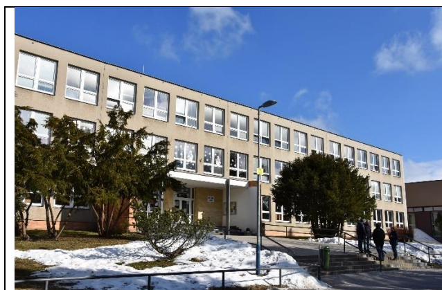
Obrázek 6: Jižní fasáda – vstup do objektu
