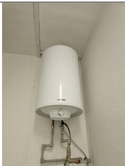
Obrázek 27: Ohřev TV v úklidové místnosti
