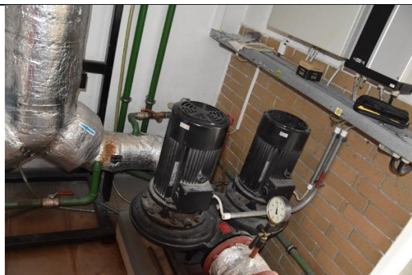
Obrázek 23: Oběhová čerpadla
