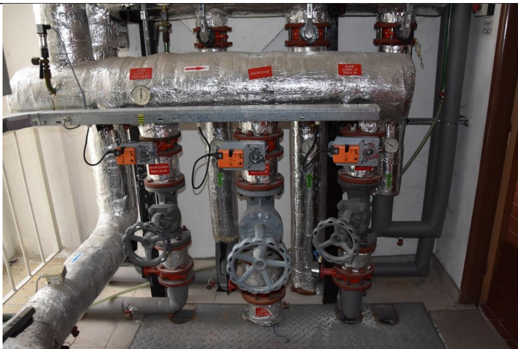
Obrázek 20: Hlavní rozdělovač
