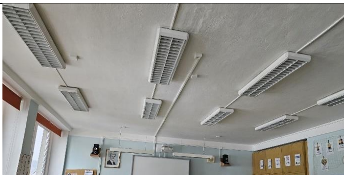
Obrázek 30: Kmenová učebna – původní osvětlení
