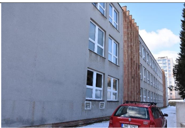
Obrázek 9: severní fasáda objektu
