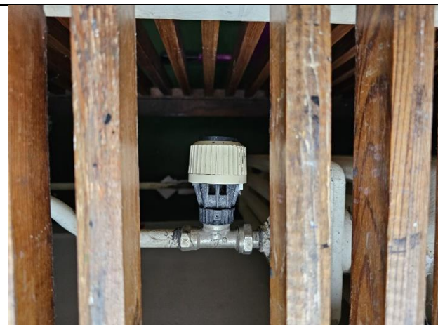
Obrázek 25: Umístění TRV na radiátorech
