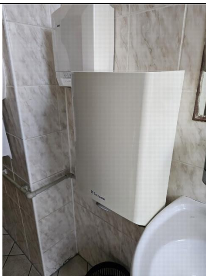
Obrázek 26: Ohřev TV na sociálním zařízení (společné chlapci a dívky)
