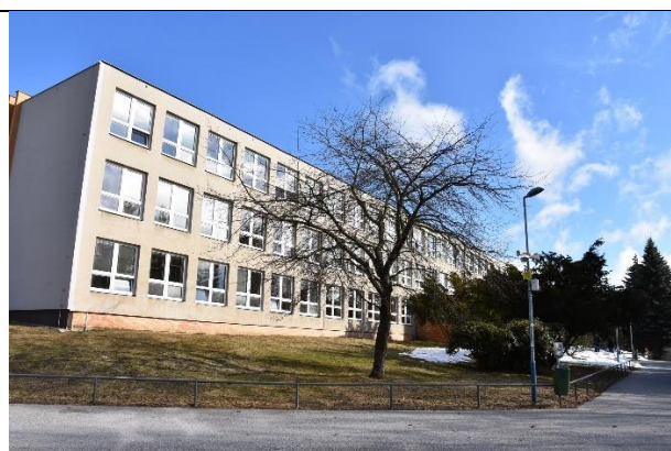
Obrázek 7: Jižní fasáda objektu
