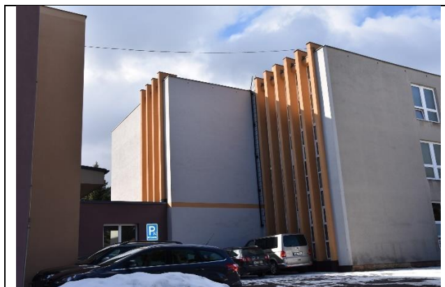
Obrázek 10: Severovýchodní roh objektu
