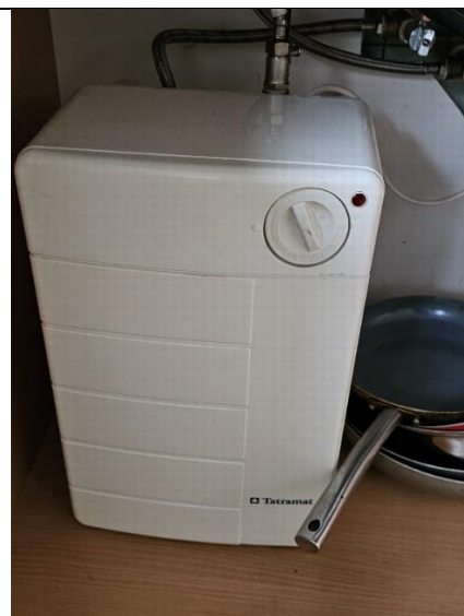
Obrázek 29: Ohřev TV v kuchyňce
