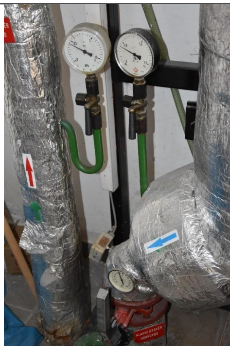
Obrázek 19: Uzávěr horkovodu
