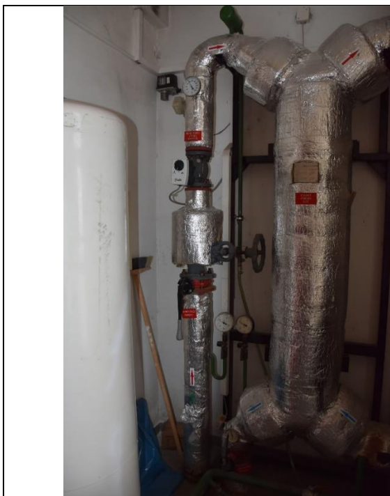
Obrázek 18: Přívod horkovodu
