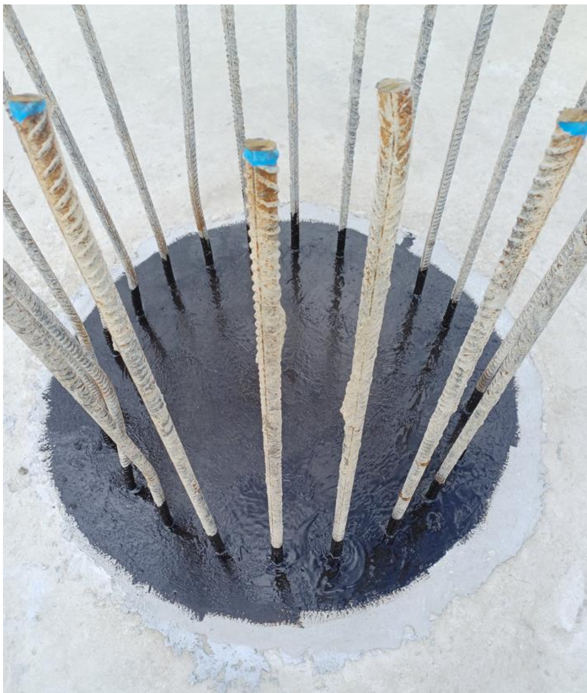
Provedení izolace proti vodě ↑
