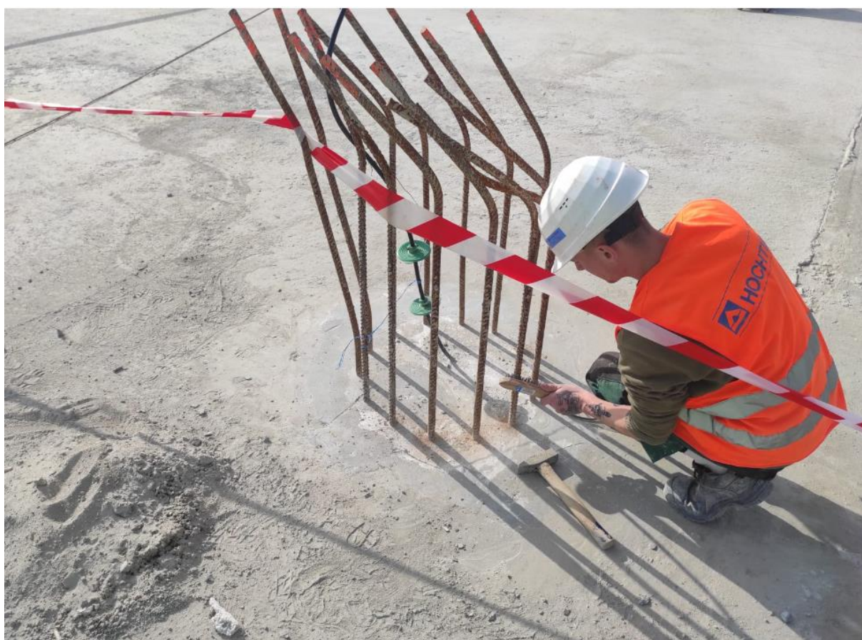
Čištění po zalití hlavy piloty ↑
