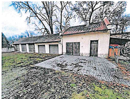
Obr. Současný stav garáží a ploch
