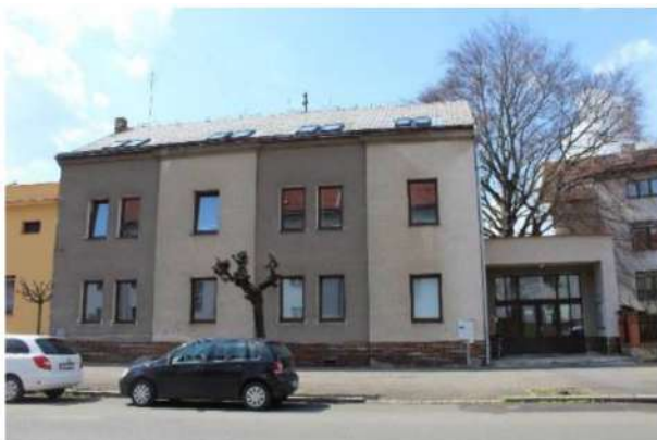
Obr. 13: Pohled III – budova B
