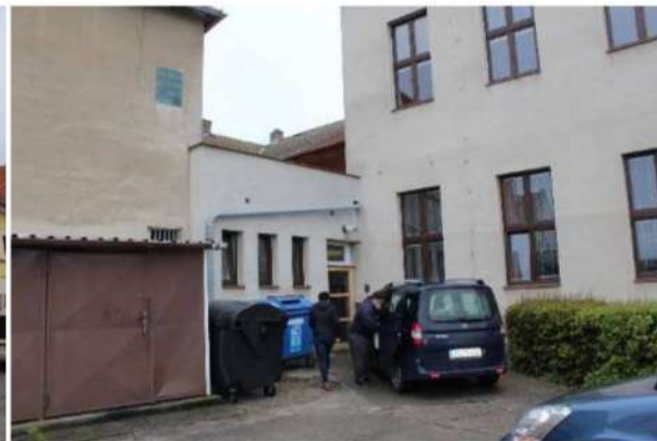
Obr. 41: Pohled ze dvora – Budova č.p. 6
