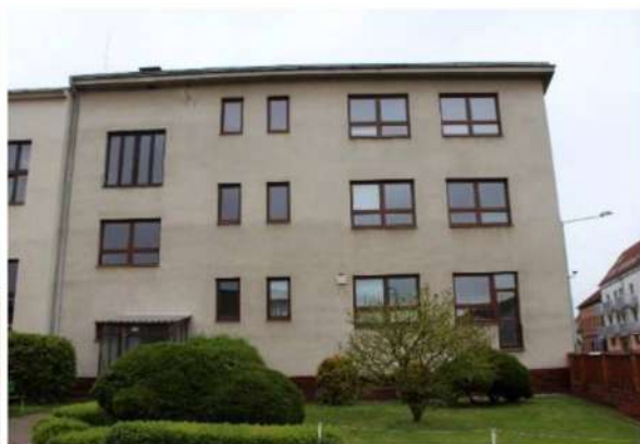
Obr. 37: Pohled ze dvora – Budova č.p. 3
