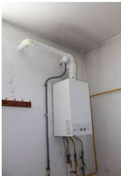
Obr. 25: Nástěnný kotel
