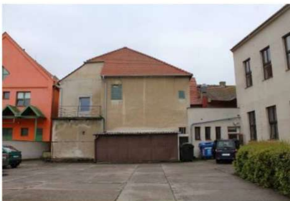
Obr. 43: Pohled ze dvora – Budova č.p. 6
