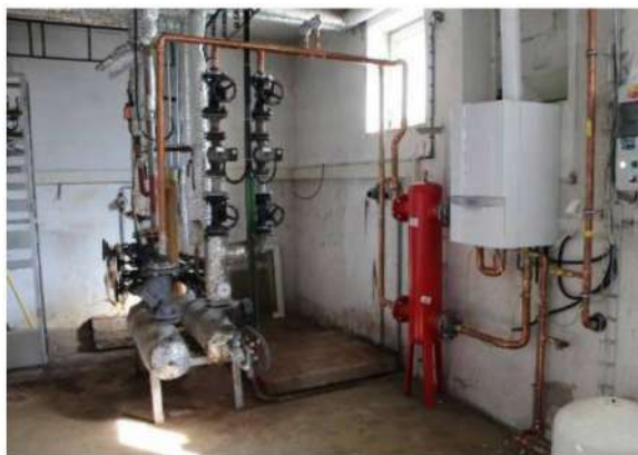
Obr. 8: Zdroj tepla a R+S pro tělocvičnu
