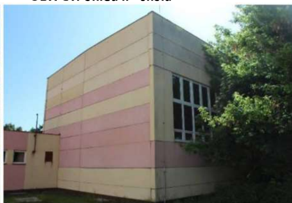
Obr. 5: Pohled IV - tělocvična
