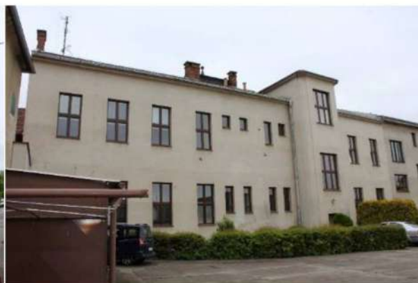
Obr. 39: Pohled ze dvora – Budova č.p. 4
