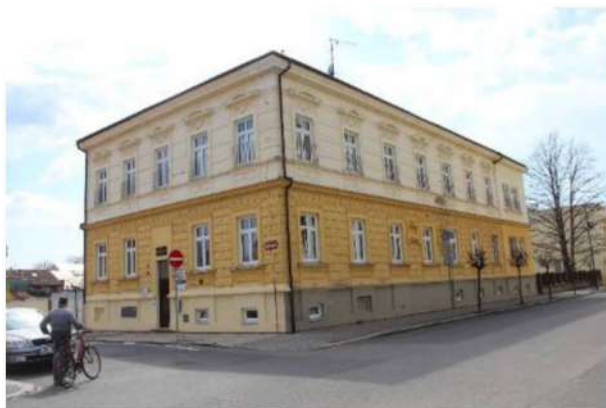
Obr. 21: Pohled z ulice
