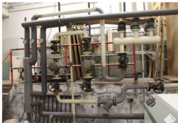
Obr. 24: HVDT, otopný okruh, rozdělovač ÚT
