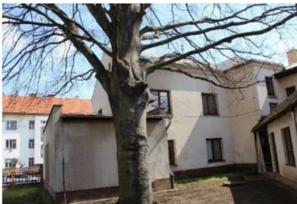
Obr. 14: Pohled IV – budova B
