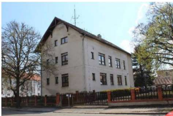
Obr. 11: Pohled I – budova A
