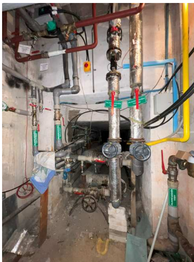
Obr. č. 1.1.3f – Přívodní potrubí z kolektoru na patě objektu
