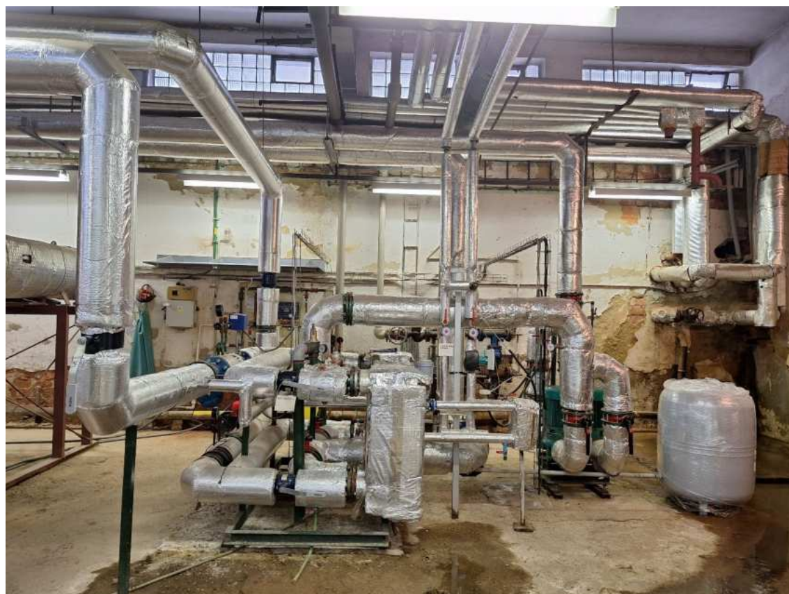
Obr. č. 1.1.5c – Výměňíková stanice, měřič tepla (pavilon D')
