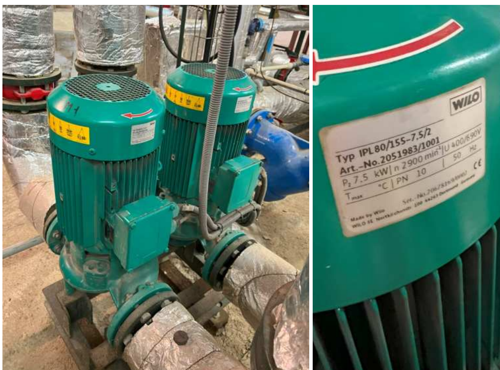
Obr. č. 1.1.5e – Čerpací práce, výměník ÚT (pavilon D')
