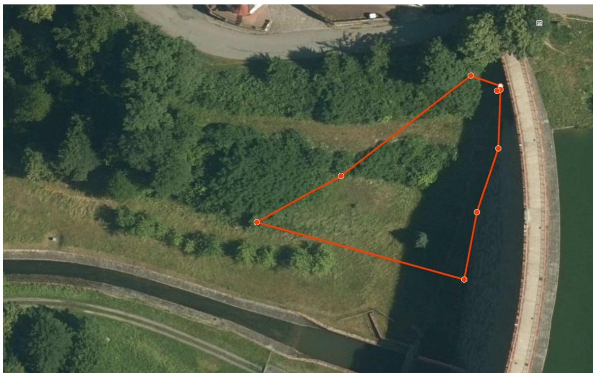
Vzdušná část hráze – pravý břeh.
