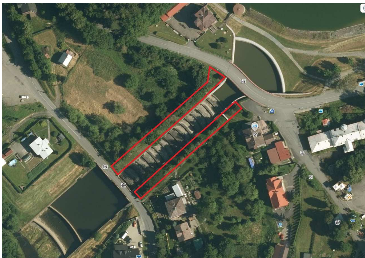
Kaskády bezpečnostního přelivu
