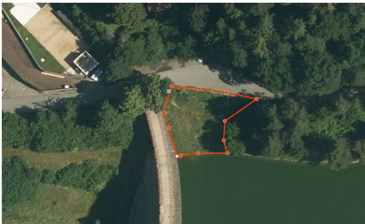
Návodní část hráze – pravý břeh.
