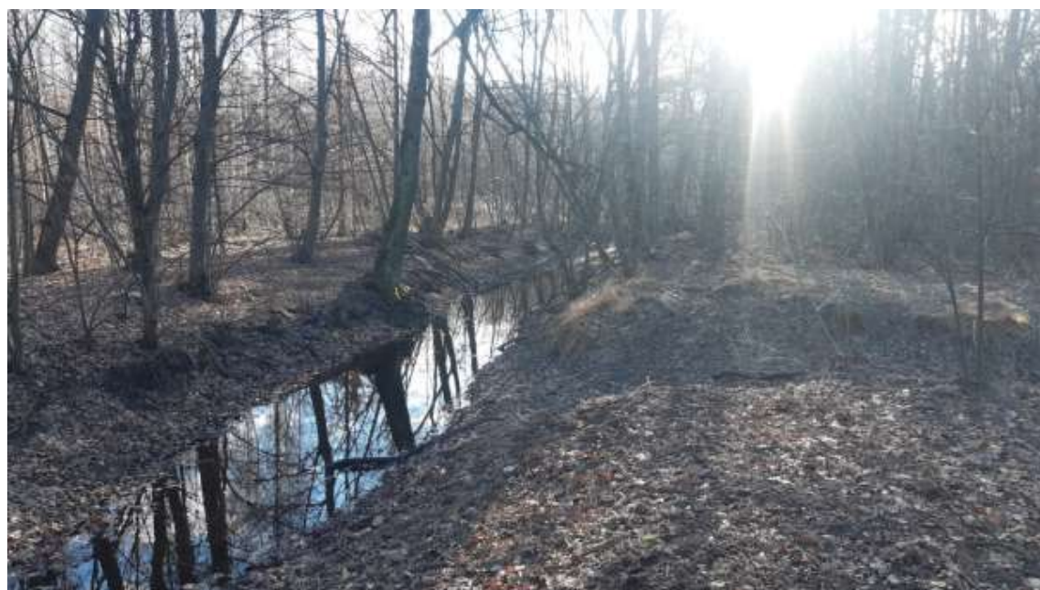
Obr. 6: VT Studená chodba v řešeném úseku
