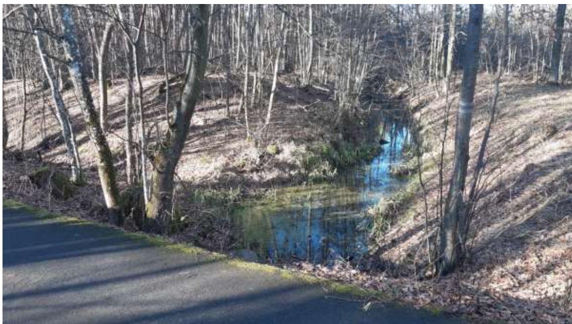
Obr. 4: Pohled na křížení VT s asfaltovou komunikací v ř. km 2,974– nyní křížení průčeznou hrázkou, uvažována realizace stavítka s propustkem pod cestou. Vlevo navazující otevřený kanál.
