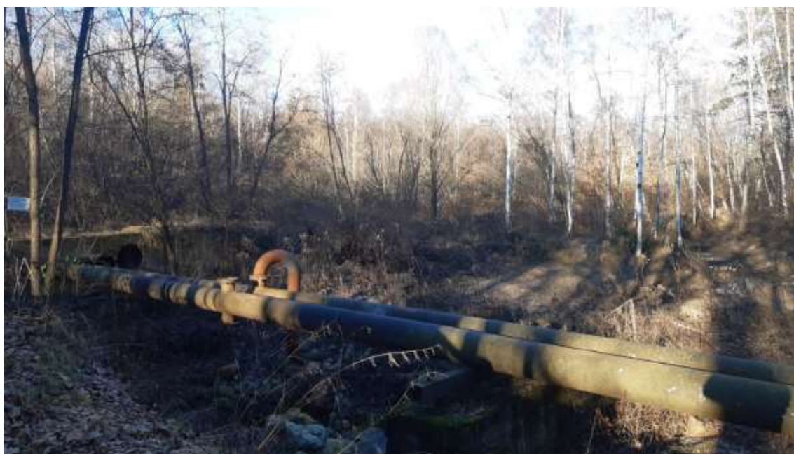
Obr. 2: Pohled na místo vyústění potrubí v době, kdy neprobíhá napouštění
