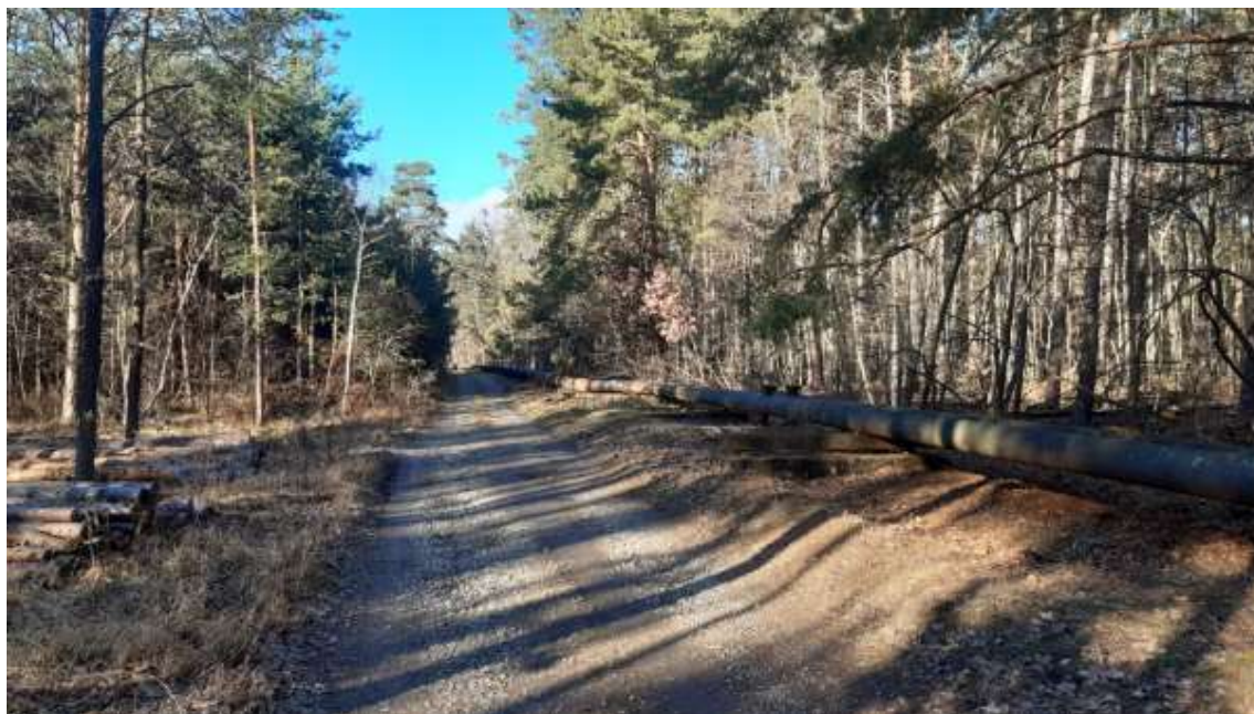
Obr. 1: Pohled na přívodní potrubí, kterým je VT dotován
