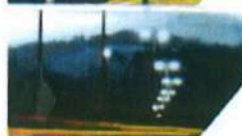
LED veřejné osvětlení Street Lighting
