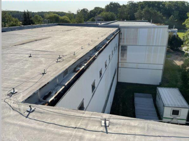
STŘECHA 5 , FASÁDA JIH PRAVÁ ČÁST
