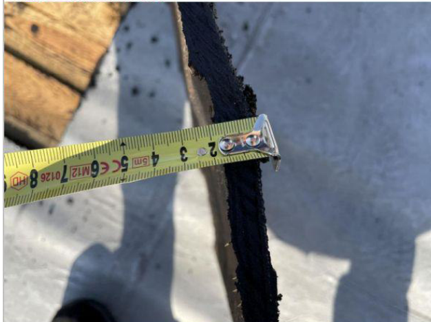
SONDA 1 tl. HYDROIZOLACE
