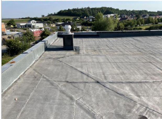
STŘECHA 4 POHLED NA SEVERNÍ LEVOU ČÁST
