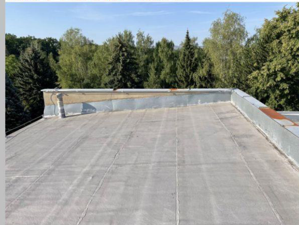
STŘECHA 3 POHLED NA JIŽNÍ ROZŠÍŘENOU ČÁST
