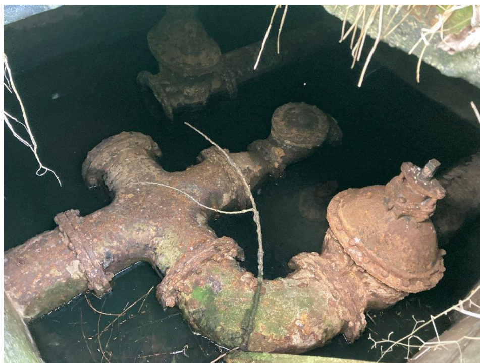
Pohled do šachty levý břeh:
