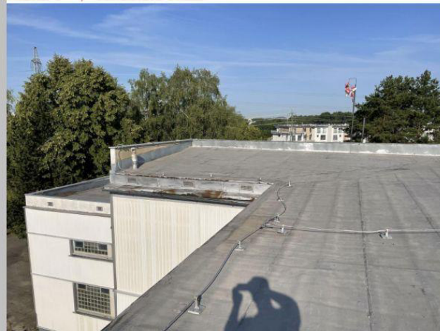
STŘECHA 8 , JIHOZÁPADNÍ POHLED
