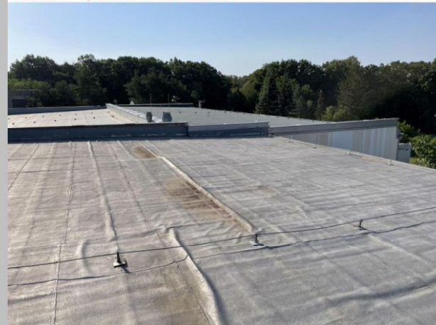
STŘECHA 6 , ZVŘÁSNĚNÍ HYDROIZOLACE
