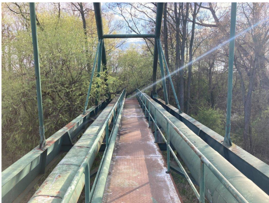
Celkový pohled most:
