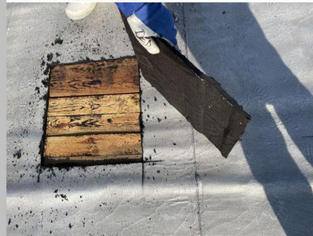
SONDA 1 DVOUPLÁŠTOVÁ STŘECHA
