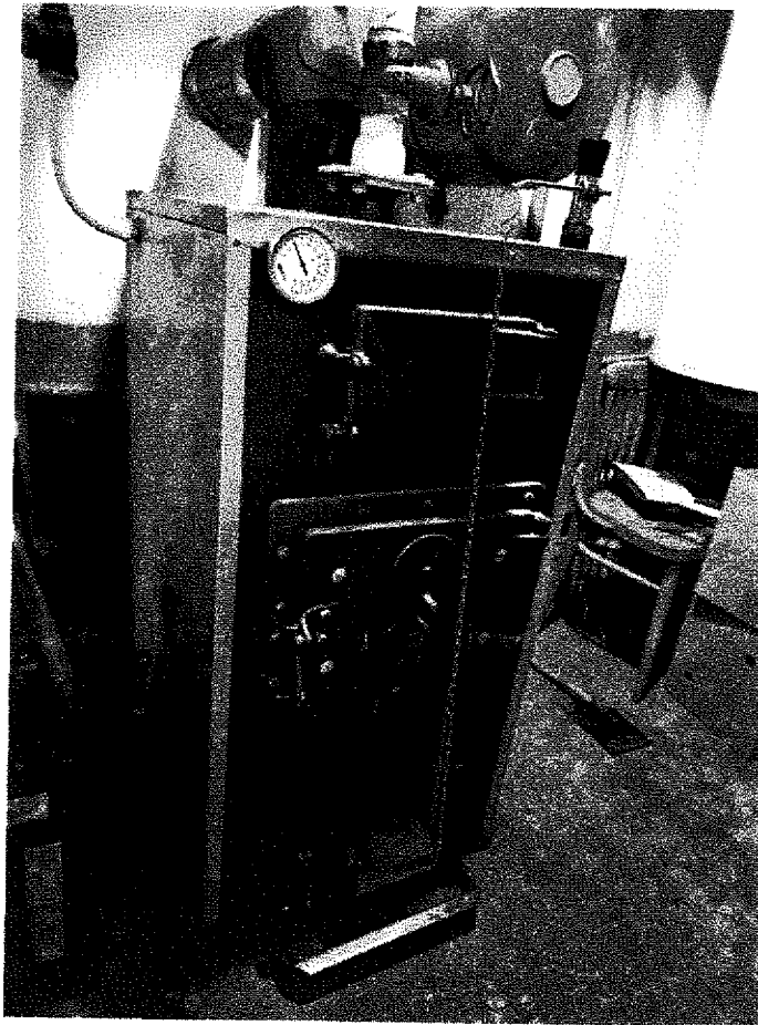
Celkový pohled na kotel
