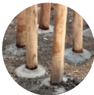
kotvení stojin do betonu
