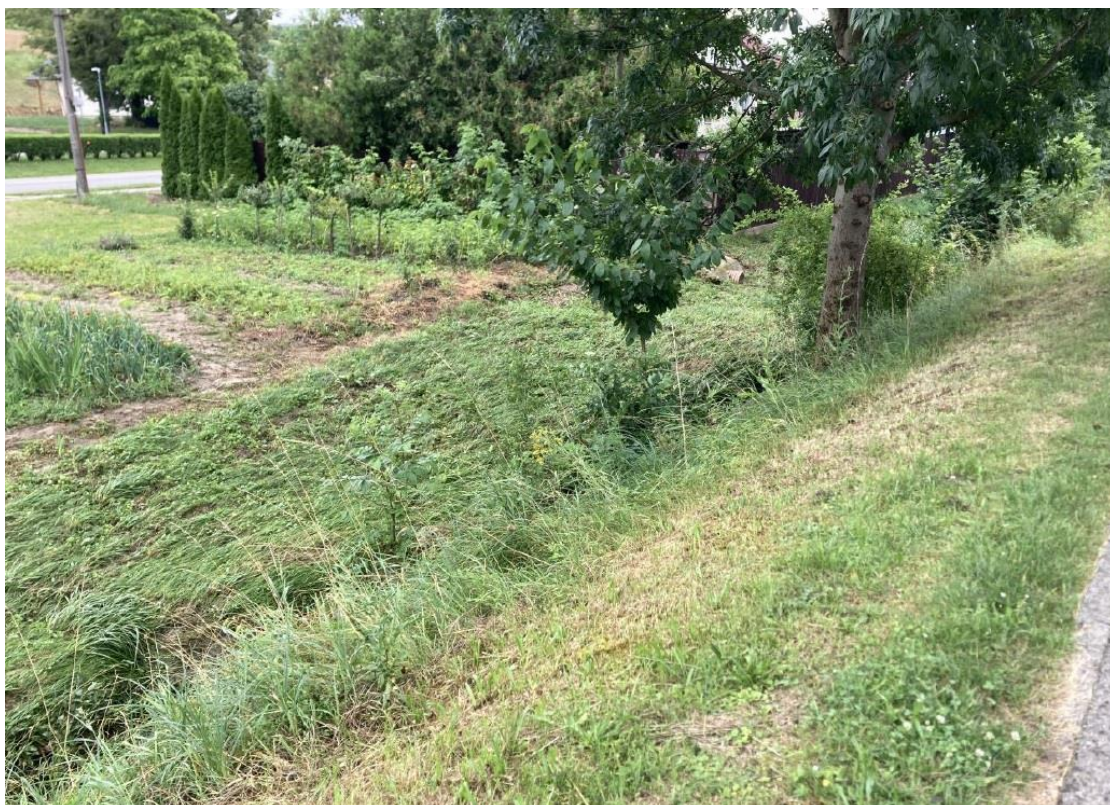
Obr. č. 3: Úsek 1, ř. km 2,35, pohled po proudu, na LB zřetelně slehlá tráva po vysokých průtocích z 1.7.2024 - zcela zaplněné koryto, vyběžení na LB
