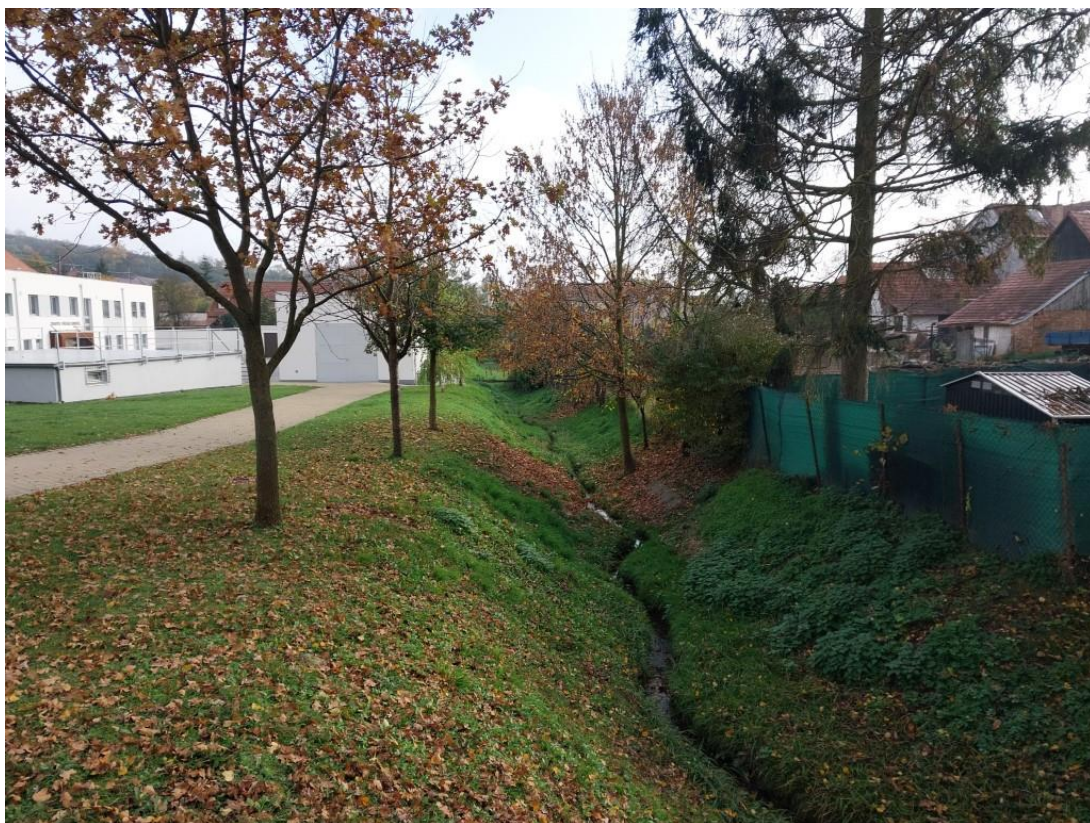
Obr. č. 8: Konec úseku 1, pouze napojení na stávající niveletu, stav koryta bezproblémový.
