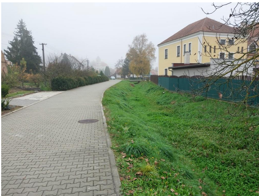
Obr. č. 7: Úsek 1, ř. km 3,45, pohled po proudu
