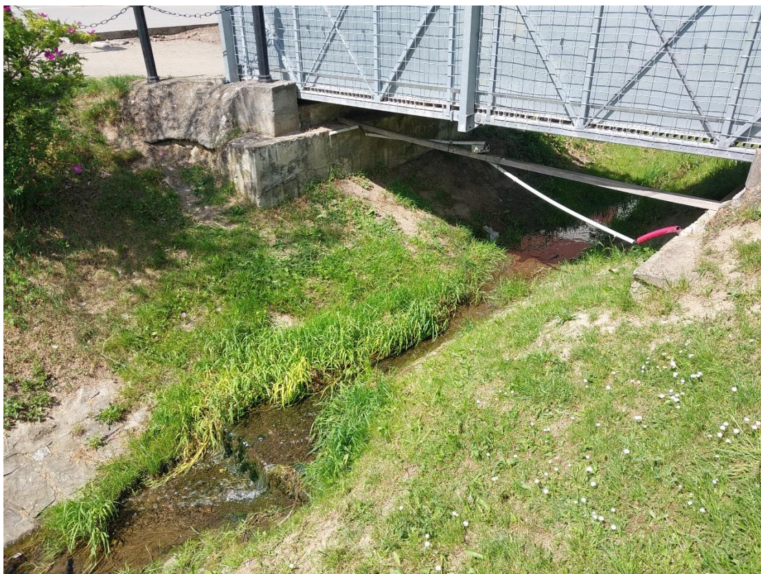
Obr. č. 5: Začátek úseku 2, ř. km 3,037, pohled proti proudu, pevná niveleta bez nánosů pro napojení dána pevným bet. prahem
