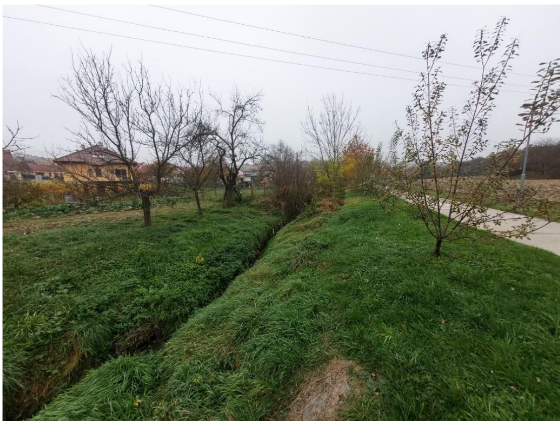
Obr. č. 4: Úsek 1, ř. km 2,5, pohled proti proudu
