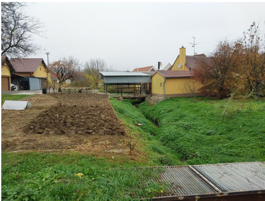
Obr. č. 2: Úsek 1, ř. km 2,35, pohled po proudu, nánosy zejména na LB
