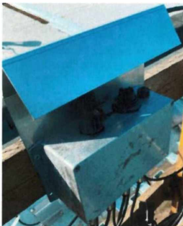
Obr. 5 - Montáž RSS řídicí jednotky včetně ochranné stříšky
