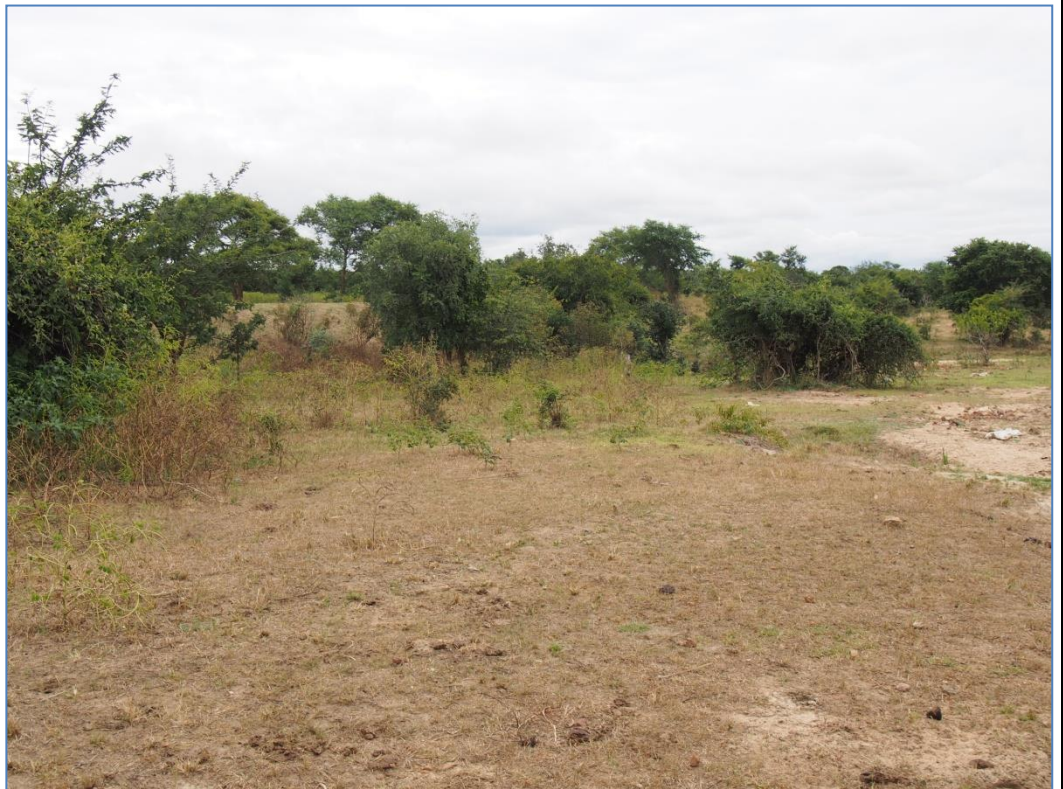
Vzdušná strana hráze
