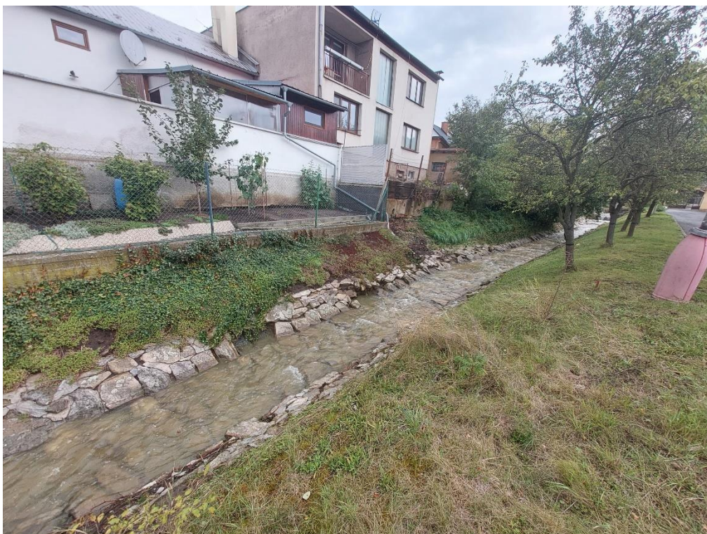
Obr 4 poškozená dlažba v řlkm cca 1,67 s vysokým podílem velikostně nevhodného kameniva. Toto bude v konečném důsledku zvyšovat podíl dlažeb, které bude nutné provést nově.
