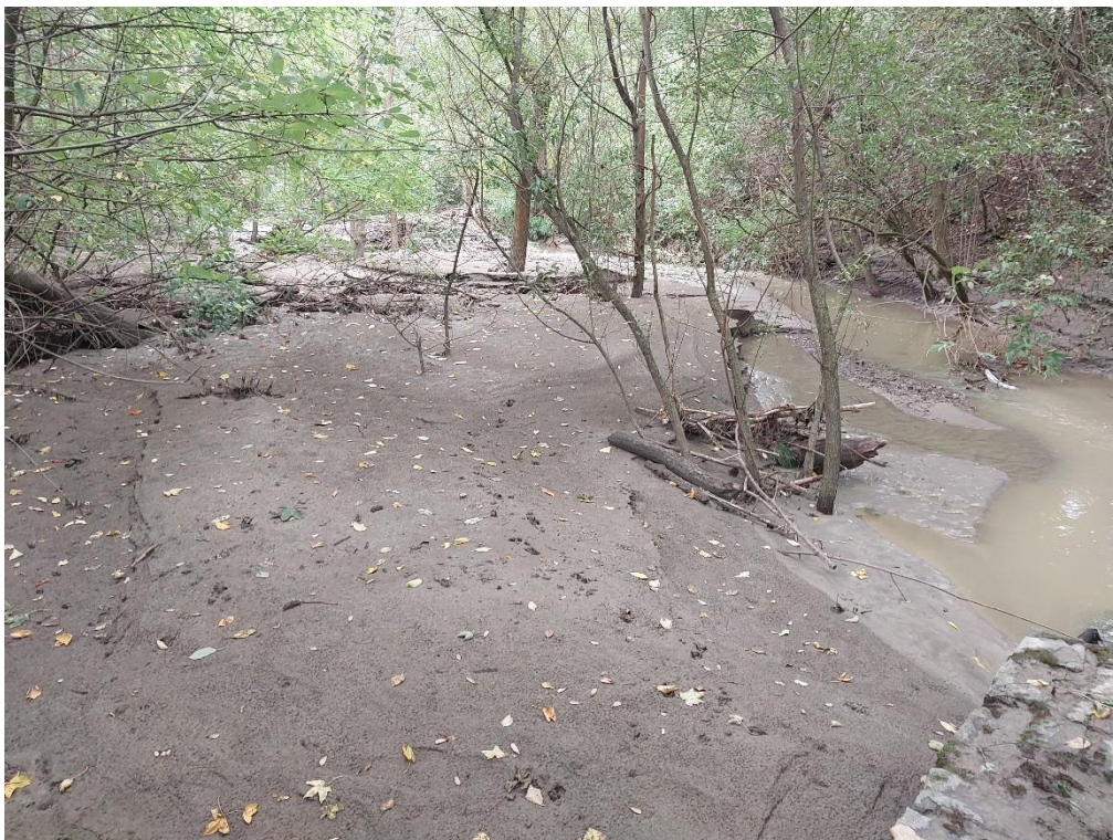
Obr 11 zanešený retenční prostor přehrážky v ř.km 2,43
