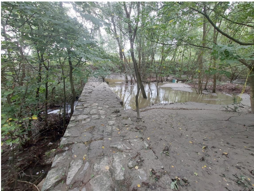
Obr 7 zanešená přehrážka v ř.km 2,2
