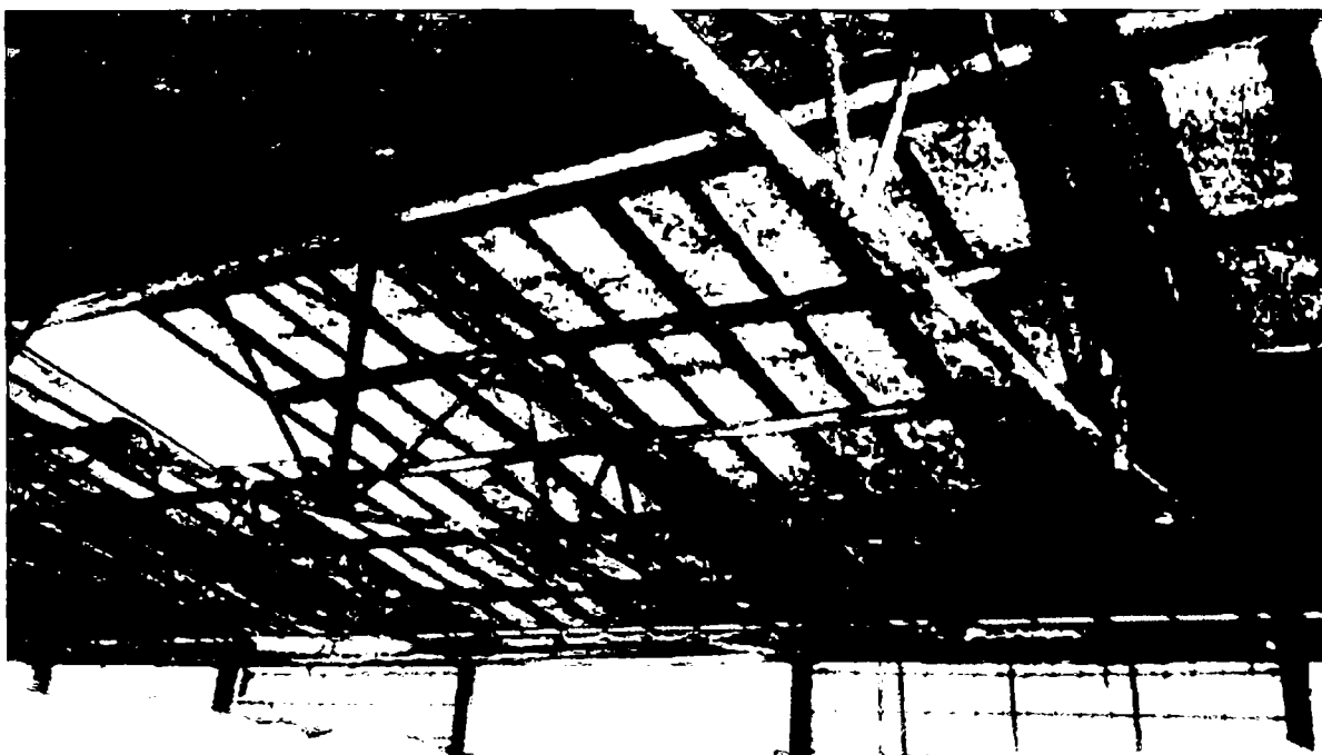
Nosné konstrukce objektu D
