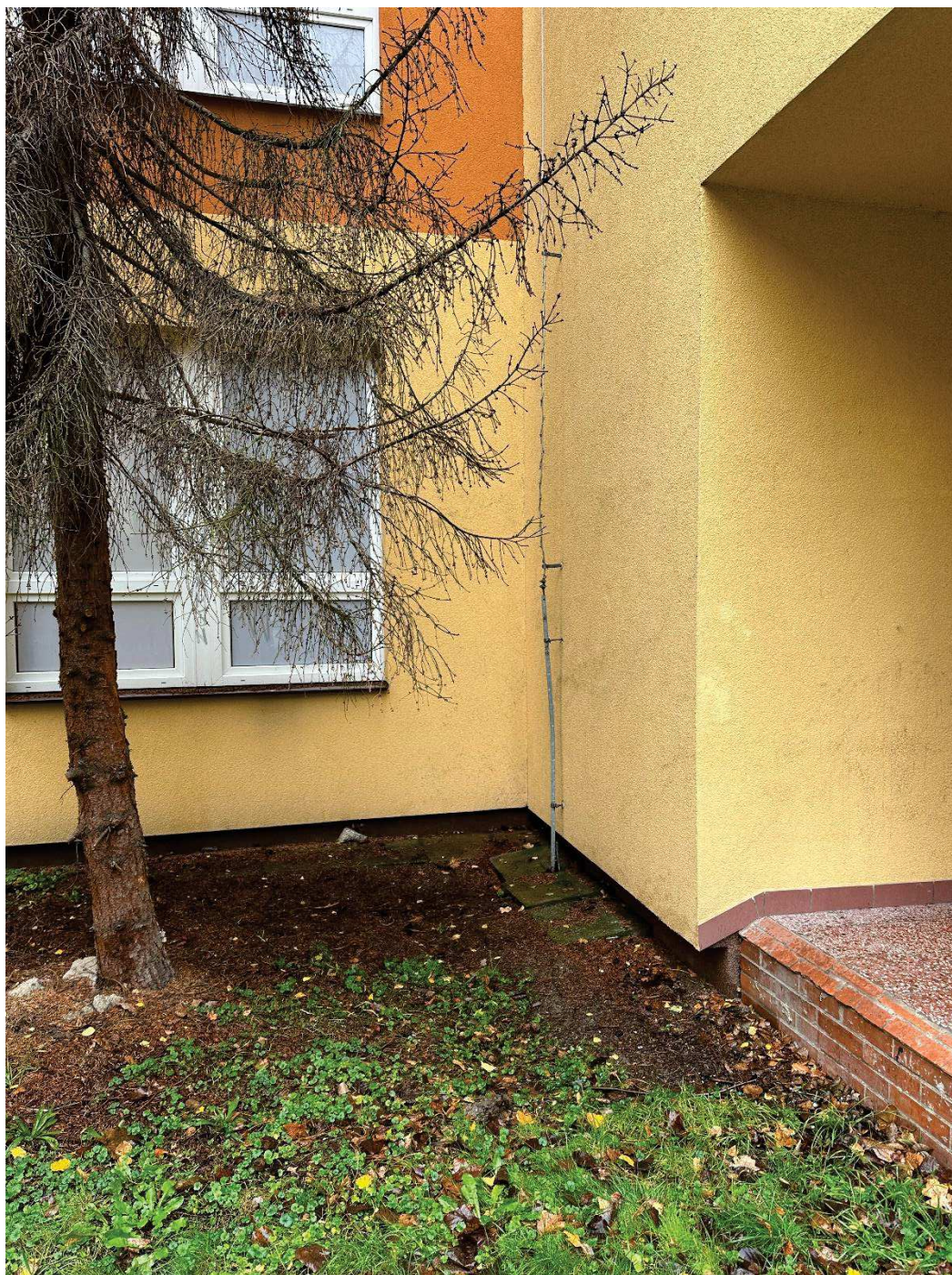
Foto prostupu v objektu s vyznačením místa vstupu:
