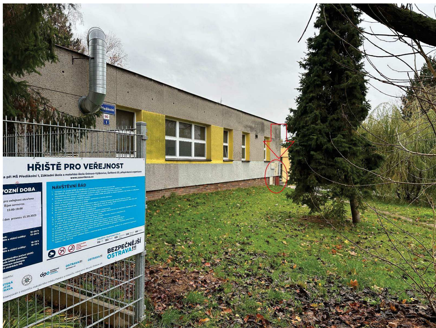
Foto prostupu v objektu s vyznačením místa vstupu:
