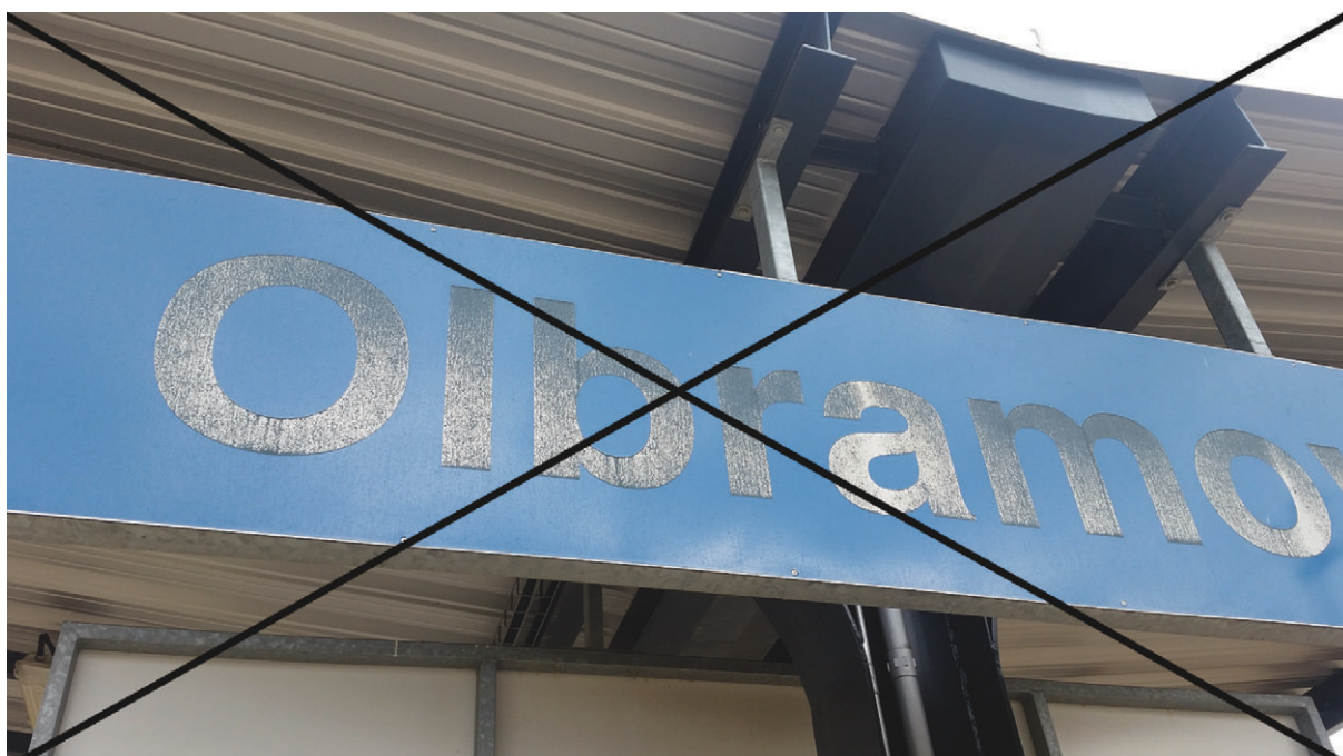
Příklad zakázaného řešení – vyřezaná fólie nalepená na plechovou tabuli
