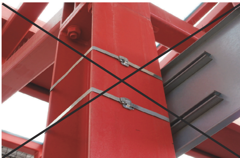
Příklad nevhodného uchycení – pásky poškozují protikorozi ochranu sloupu.
