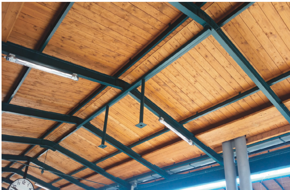
konzoly pro uchycení tabule (konzoly připravené dodavatelem zastřešení)
