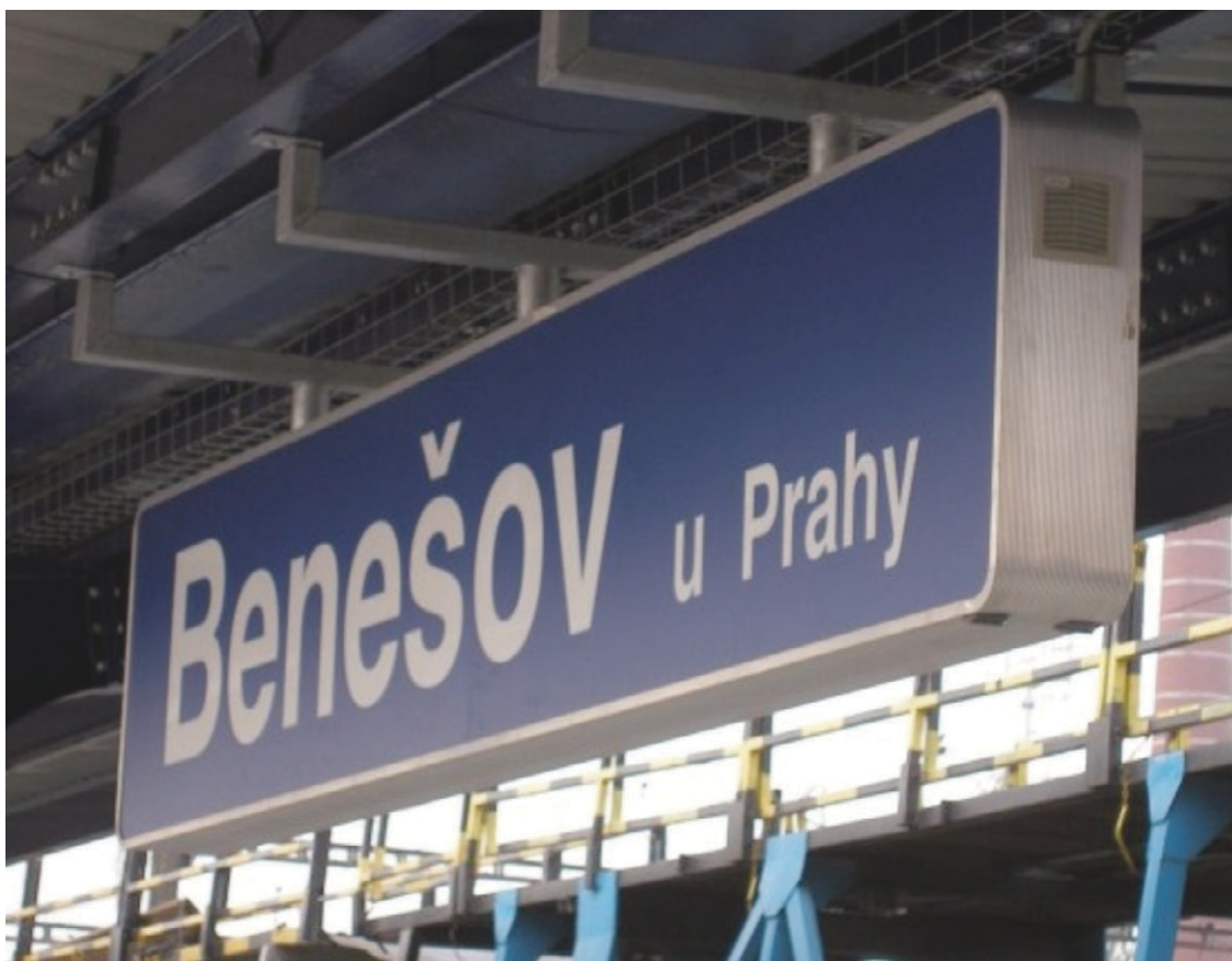
Příklad prosvětleného butonu s větrací mřížkou
