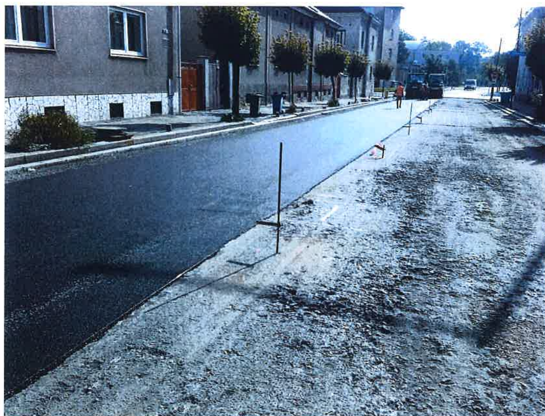
Vyrovnání štěrkových podkladů obalovaným kamenivem
