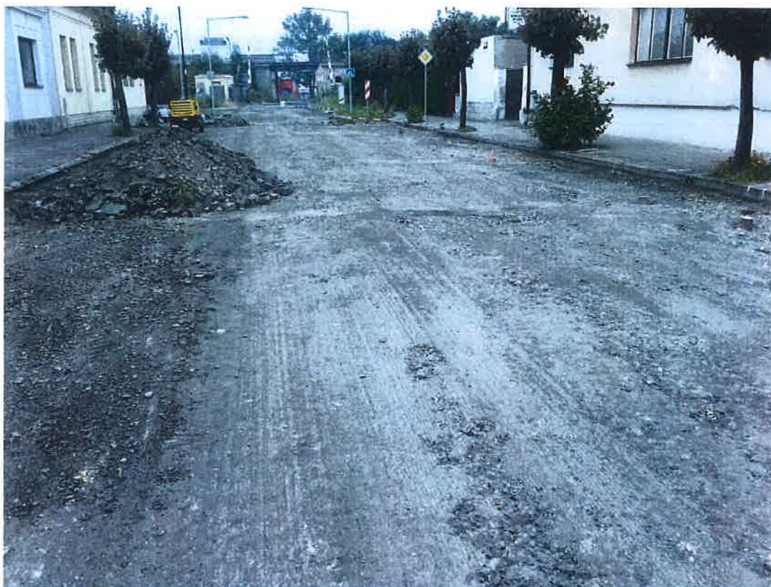
Stav po odfrézování živičného souvrství
