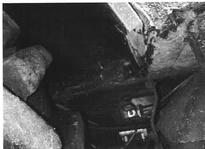
obr.6- rám traktoru (detail: spojení rámu s kabinou)
