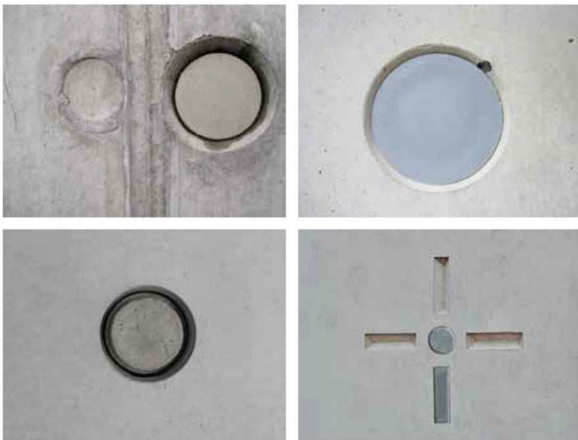
(23) Obr. F.2 – Různé způsoby uzavření spínacích otvorů
