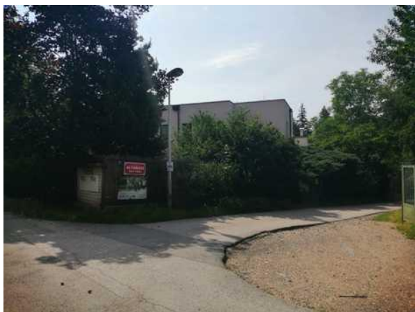
Pohled na dům č.ev. 92 z ulice Na Farkách
