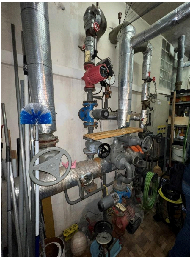
Obr. č. 1.1.9d – Podružný rozdělovač/sběrač pro Pavilony 1-5 a 6-9
