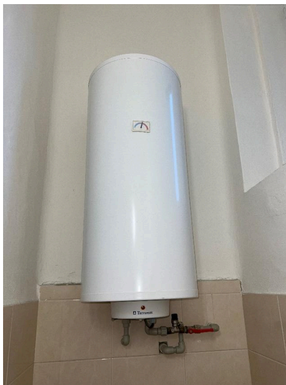
Obr. č. 1.1.2d – Elektrický bojler
