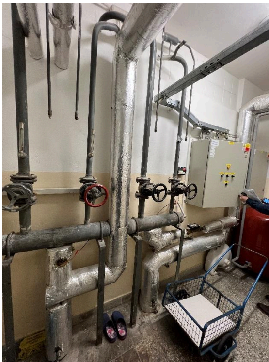
Obr. č. 1.1.10c – Podružný rozdělovač/sběrač pro Jídelnu a samostatná větev pro MŠ
