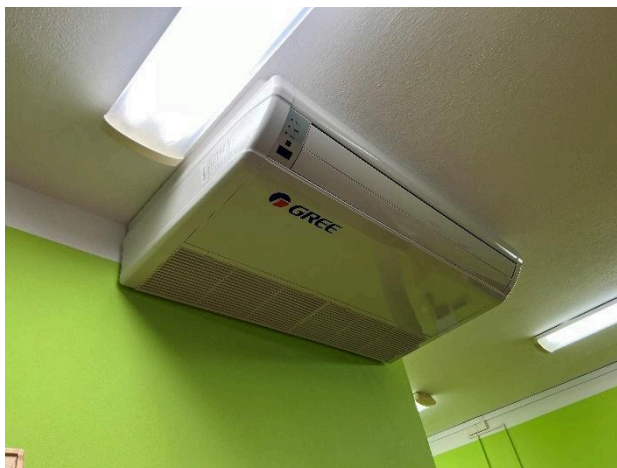
Obr. č. 1.1.10d – Vnitřní chladicí / vytápěcí jednotky
