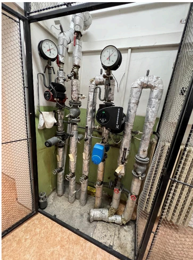
Obr. č. 1.1.9d – Podružný rozdělovač/sběrač pro Pavilony 1-5 a 6-9
