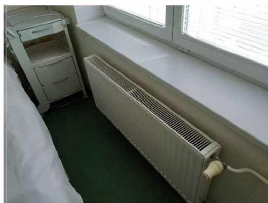
deskové otopné těleso v TRV
