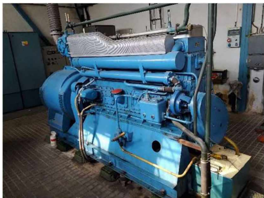
dieselagregát A4A6
