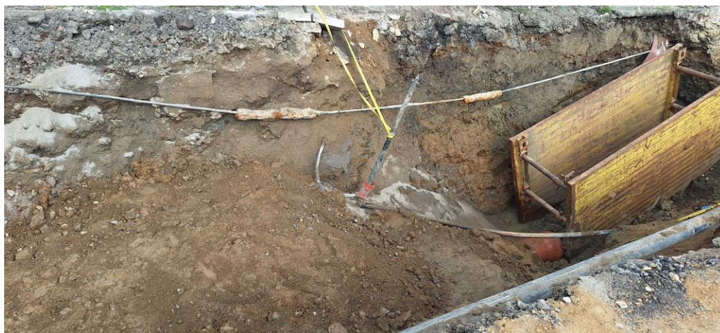
Výkop úseku od šachty ŠSB1 – ŠSB2
