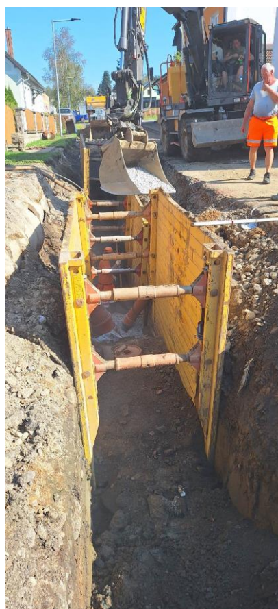
Výkop mezi šachtami ŠSB3 – ŠSB4
