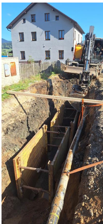
Úsek kanalizace mezi šachtami ŠSB2 – ŠSB3
