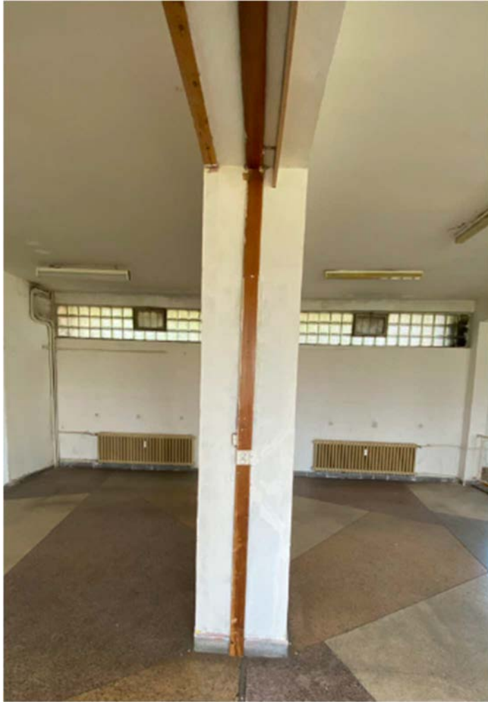
Foto 5) Zakrytí dilatace, zabudovaná elektroinstalace v 2.NP
