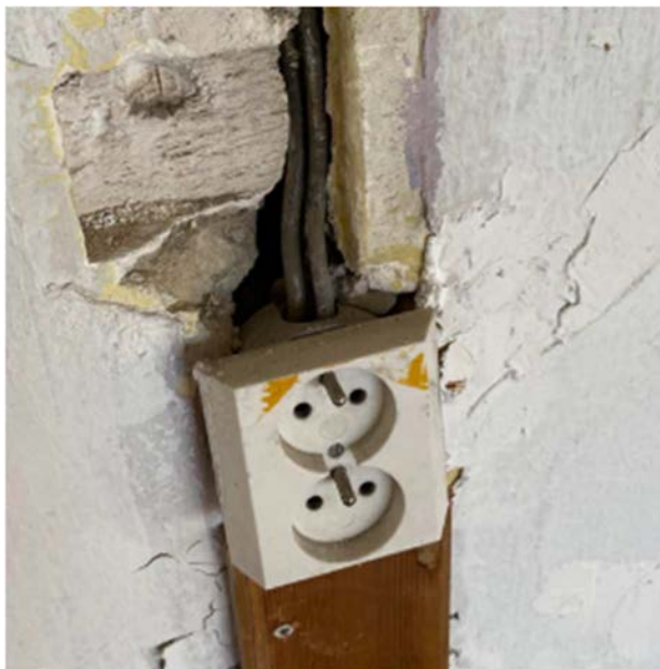
Foto 6 a 7) Elektroinstalace vedená v dilataci ve 2.NP
