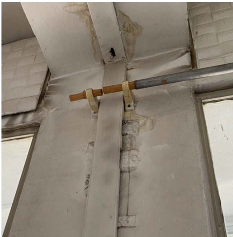
Foto 2) Zakrytí dilatace, konzoly a zabudovaná elektroinstalace v 1.NP
