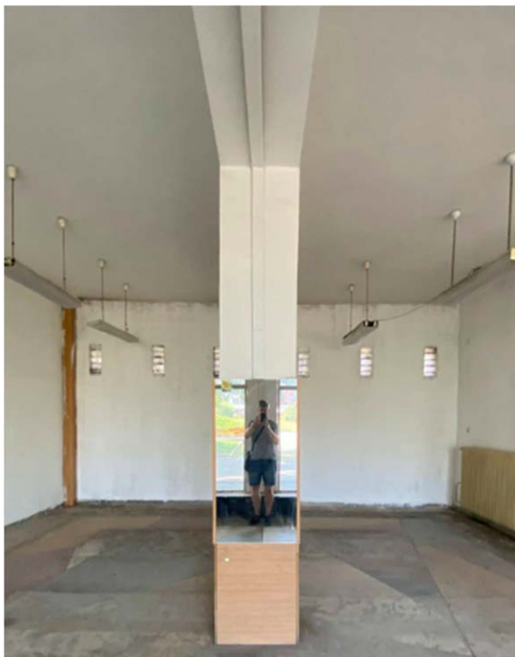
Foto 3) Zakrytí dilatace a obklad sloupů v 1.NP
