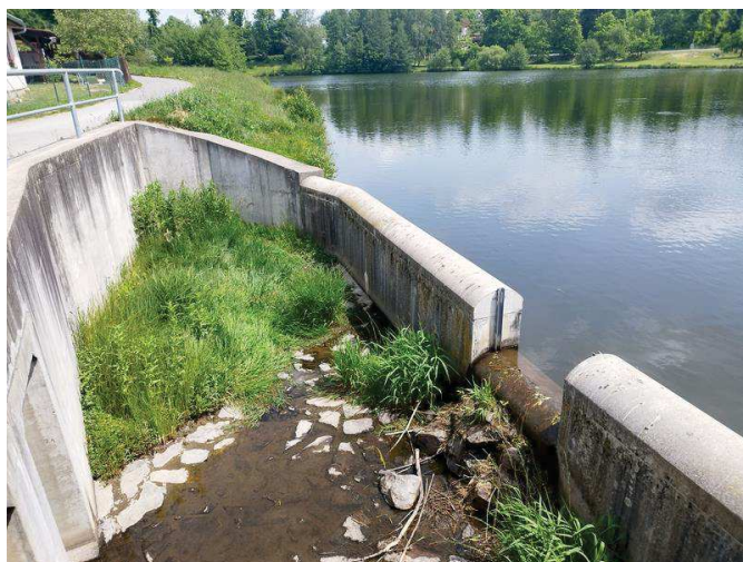
Obr. 4: Bezpečnostní přeliv průchodný pro vydru. Projektant se s požadavkem na zajištění průchodnosti pro vydru vyrovnal tak, že úplně zrušil svislou stěnu pod hranou přelivu a navrhl z čela kašny pozvolný skluz (vlevo). Vpravo - vyrovnaná hromada kamenů v místě pod oknem přelivu činí přeliv obousměrně průchozím. Pokud je průchozím i navazující most pod silnicí, zvířata mohou bezpečně migrovat podél toku, aniž by musela přecházet silnici.
