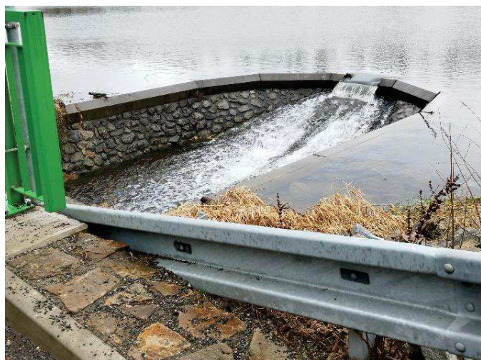
Obr. 4: Bezpečnostní přeliv průchodný pro vydru. Projektant se s požadavkem na zajištění průchodnosti pro vydru vyrovnal tak, že úplně zrušil svislou stěnu pod hranou přelivu a navrhl z čela kašny pozvolný skluz (vlevo). Vpravo - vyrovnaná hromada kamenů v místě pod oknem přelivu činí přeliv obousměrně průchozím. Pokud je průchozím i navazující most pod silnicí, zvířata mohou bezpečně migrovat podél toku, aniž by musela přecházet silnici.
