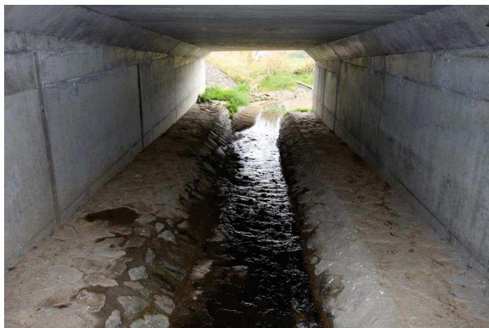
Obr. 47: Most s oboustrannými kamennými bermami je dobře průchozí pro vydru i pro široké spektrum dalších živočichů
