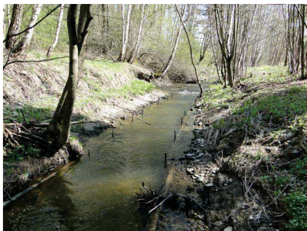
Obr. 24: Vegetační opevnění břehu – zbytky kulatiny upevněné roxory (vlevo), kulatina v patě břehu (vpravo)
