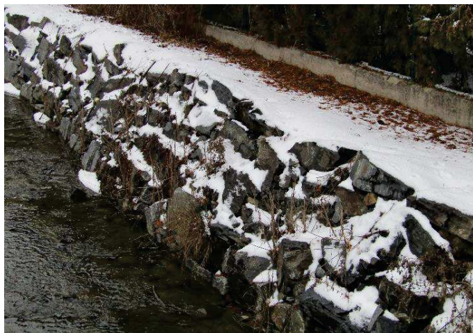
Obr. 25: Kamenná rovnánina (vlevo), zpřírodněná kamenná rovnánina (vpravo)
