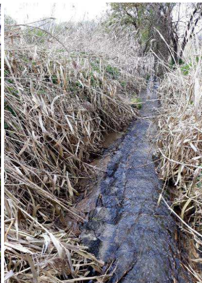
Obr. 27: Působení renaturačních procesů – rozpad a odnos opevnění břehů kulatinou (vlevo), odnos opevnění břehů kulatinou a břehové nátrže (uprostřed), obtékání opevnění (dna a paty břehů) betonovými prefabrikáty (vpravo)
