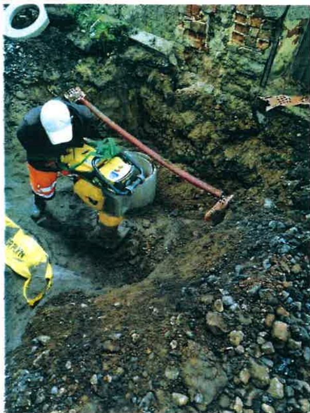
Výměna zásypů rýh UV
