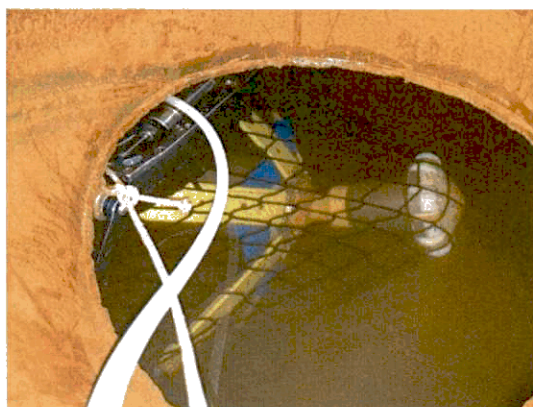
Obrázek 10: Ruční vyjmutí nástroje PipeDiver po zachycení do připravené sítě
