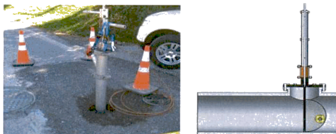
Obrázek 3: Vyjmutí zařízení SmartBall
