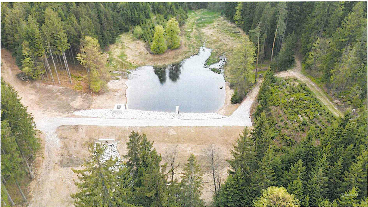
Dokončená zrekonstruovaná nádrž.
