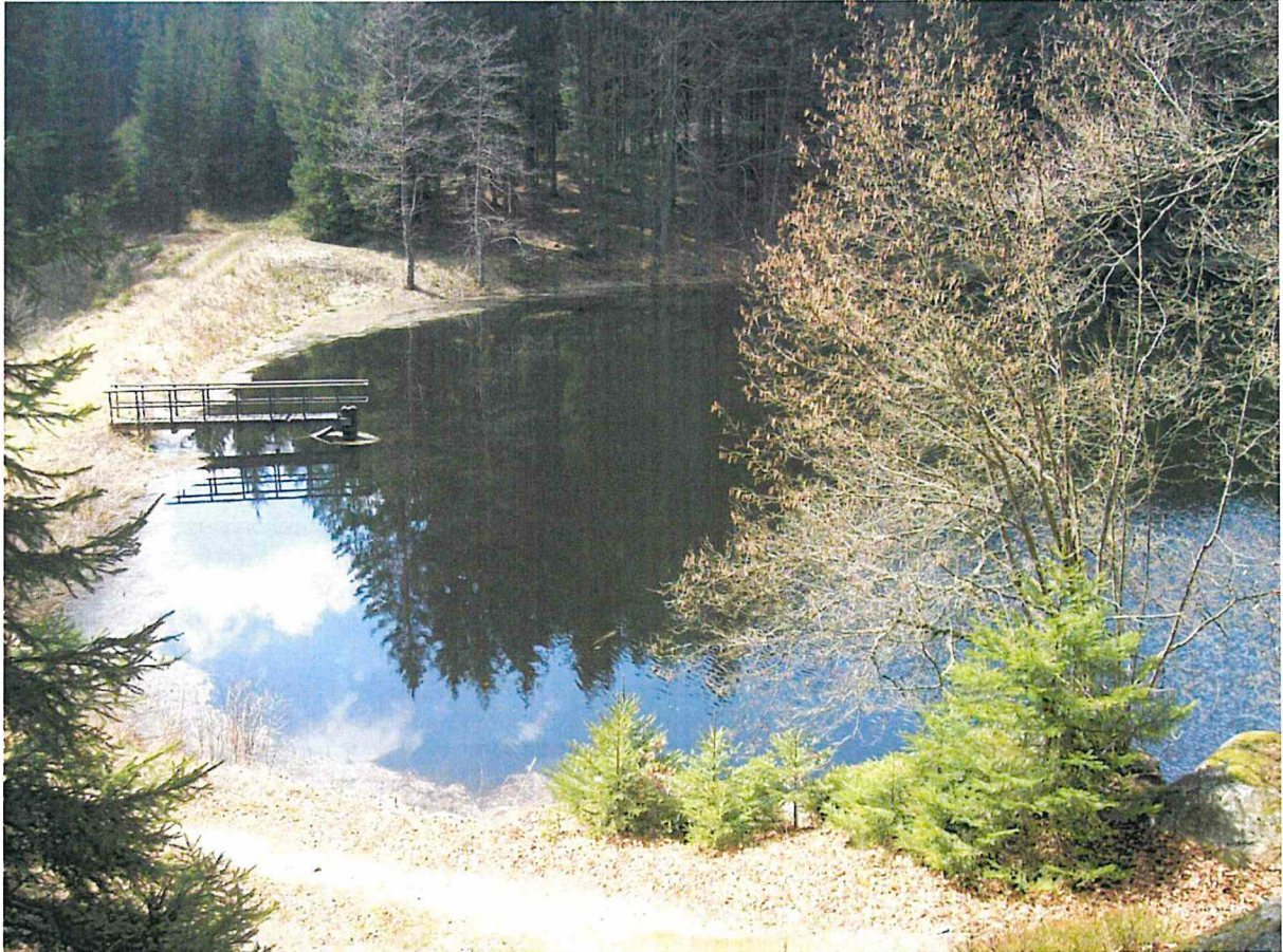
Pohled na vodní nádrž před rekonstrukcí, těleso hráze a požerák.
