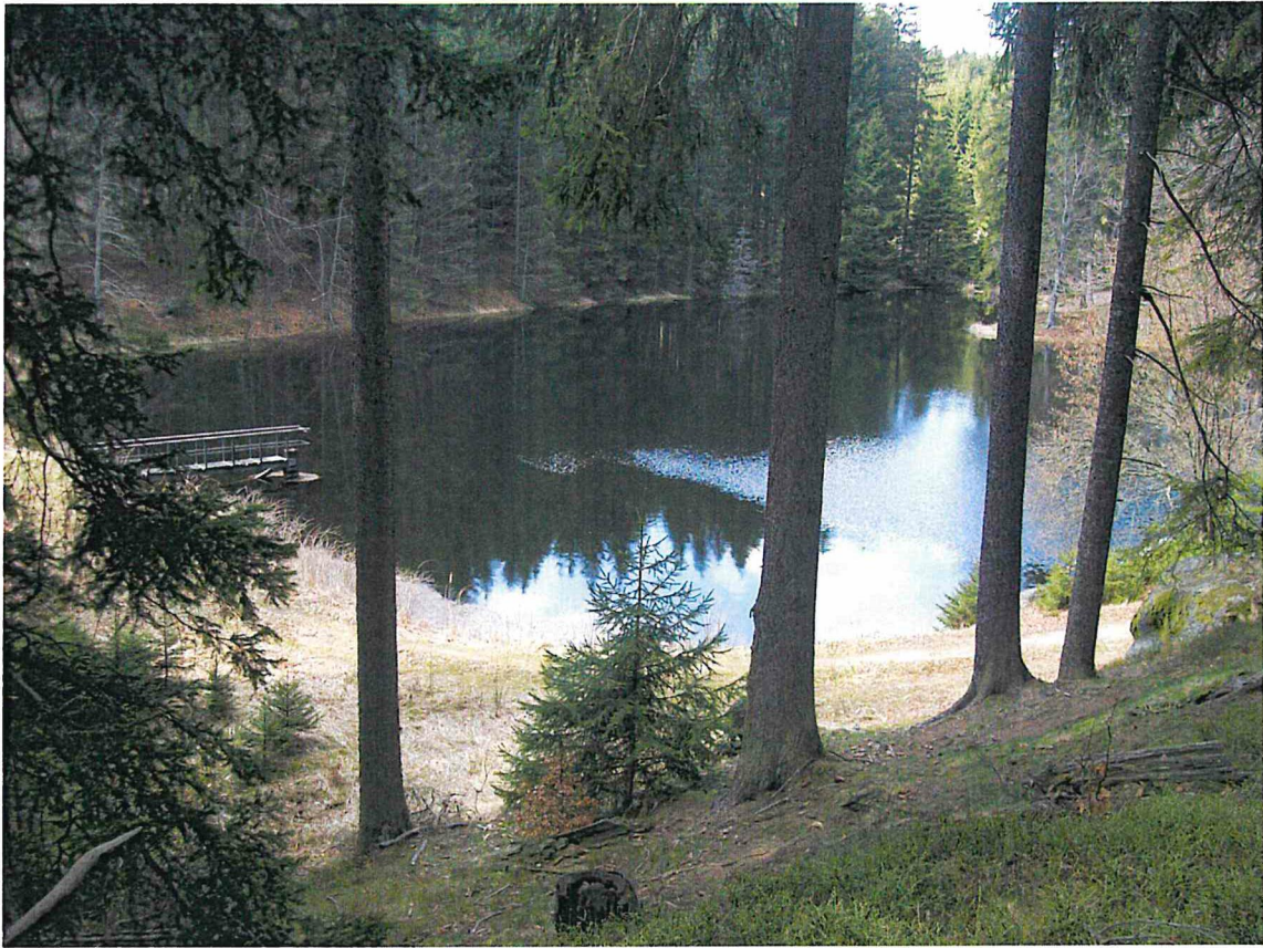
Pohled na vodní nádrž před rekonstrukcí, požerák a zátopa.
