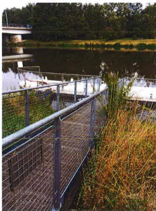
Detailní pohled na vývaziště.
