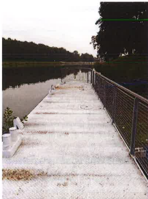
Pohled na vývaziště ve směru proti toku vody.
