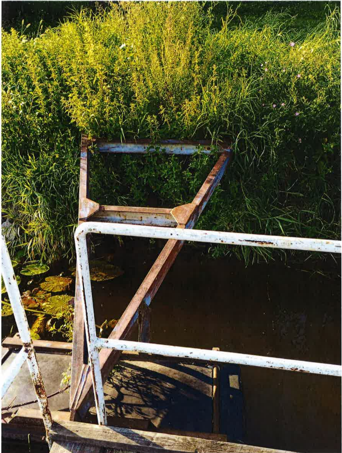
Detail ukotvení tělesa přístavního můstku.
