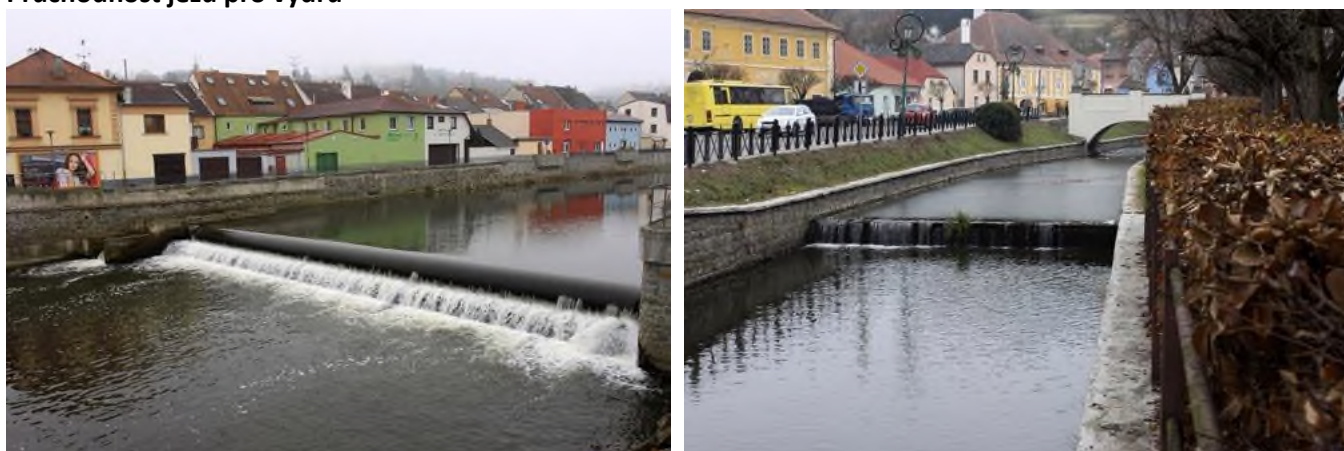
Obr. 43: Jezy mezi svislými nábrežními zdmi představují nepřekonatelné bariéry pro vydra, ale i pro další semiakvatické druhy. Zvířata migrující podél vodního toku (vodním tokem) se musejí od překážky vracet až k místu, kde mohou vylézt na břeh, a snaží se překážku obejít. Přitom musejí často překonávat silnice a další riziková místa. Za bariéru se považuje situace, kdy vydra musí k obejití překážky překonat mimo tok vzdálenost delší než 100 m nebo i vzdálenost kratší, pokud zvíře musí při obcházení překonat silnici či železnici.
