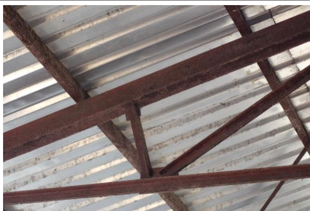
Foto 086 – pohled na ocelovou konstrukci střechy
