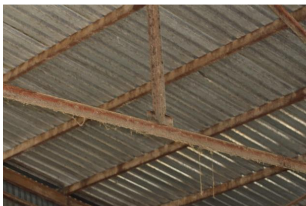
Foto 096 – pohled na ocelovou konstrukci střechy
