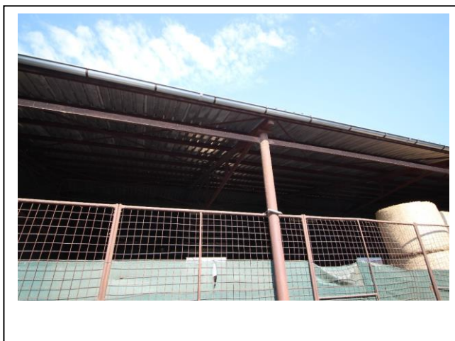
Foto 077 – pohled na ocelovou konstrukci střechy
