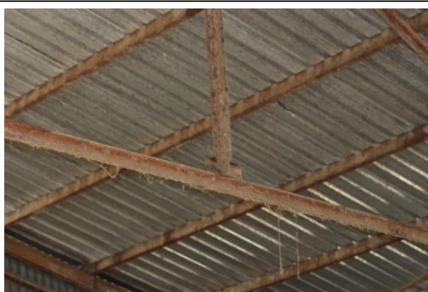
Foto 084 – pohled na ocelovou konstrukci střechy
