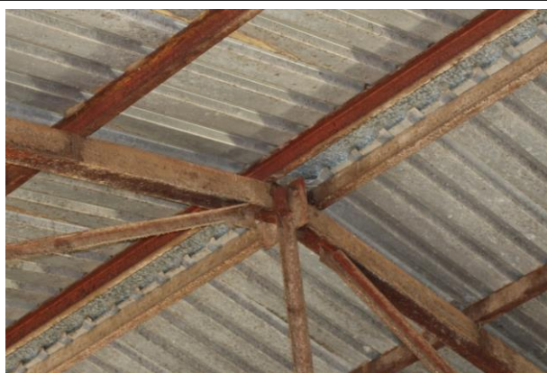
Foto 082 – pohled na ocelovou konstrukci střechy
