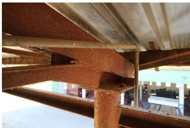
Foto 094 – pohled na ocelovou konstrukci střechy
