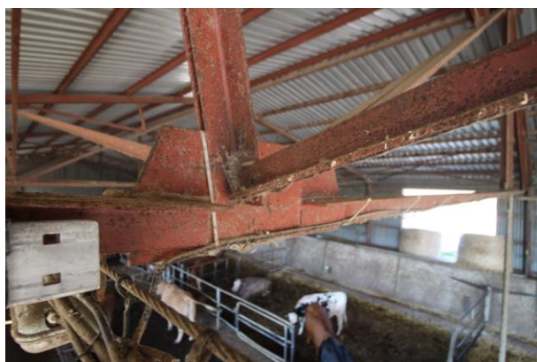
Foto 099 – pohled na ocelovou konstrukci střechy
