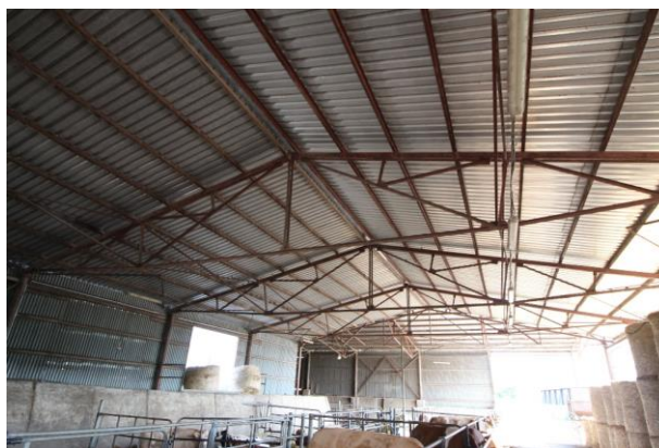
Foto 080 – pohled na ocelovou konstrukci střechy
