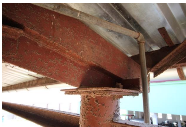
Foto 095 – pohled na ocelovou konstrukci střechy
