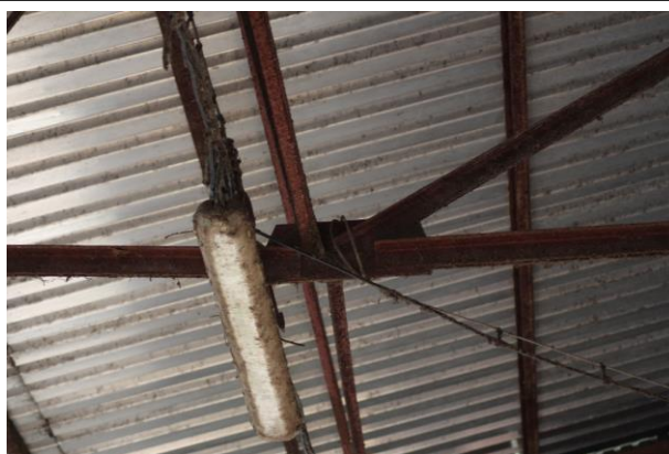
Foto 085 – pohled na ocelovou konstrukci střechy
