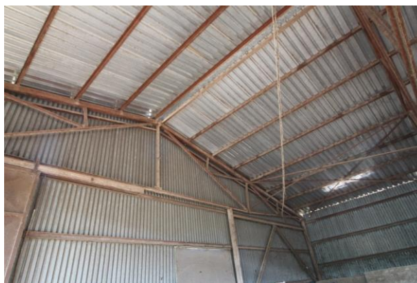
Foto 079 – pohled na ocelovou konstrukci střechy
