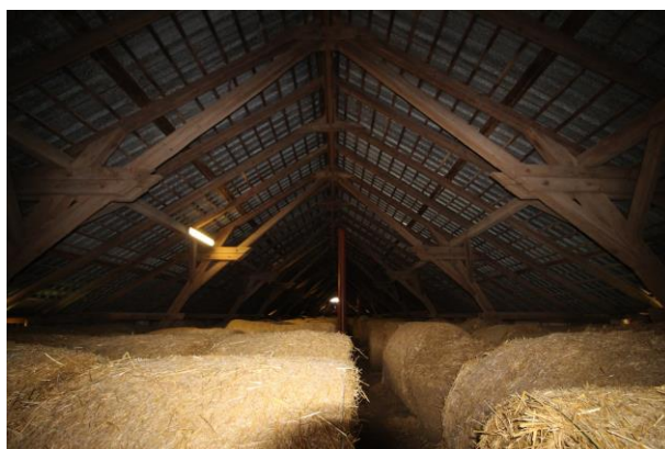
Foto 188 – pohled na dřevěnou konstrukci střechy
