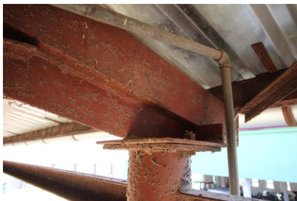
Foto 095 – pohled na ocelovou konstrukci střechy
