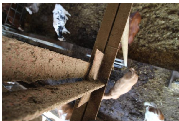
Foto 108 – pohled na ocelovou konstrukci střechy
