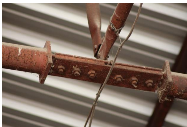
Foto 134 – pohled na ocelovou konstrukci střechy
