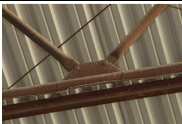
Foto 137 – pohled na ocelovou konstrukci střechy
