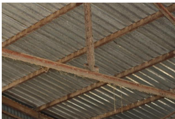
Foto 096 – pohled na ocelovou konstrukci střechy
