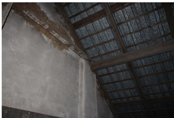
Foto 187 – pohled na dřevěnou konstrukci střechy
