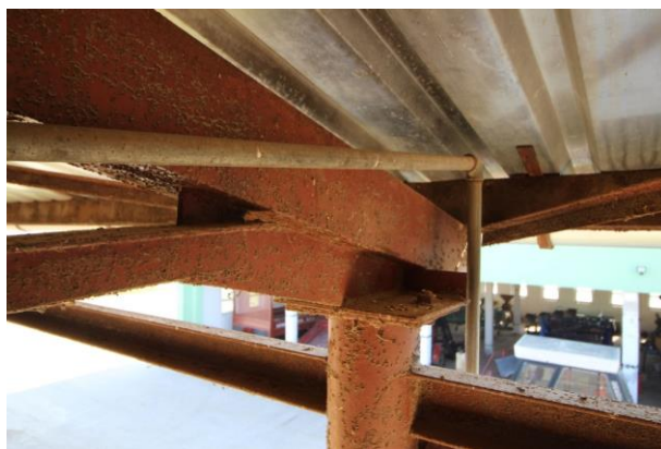
Foto 094 – pohled na ocelovou konstrukci střechy
