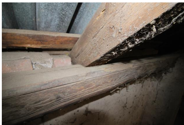
Foto 151 – pohled na dřevěnou konstrukci střechy
