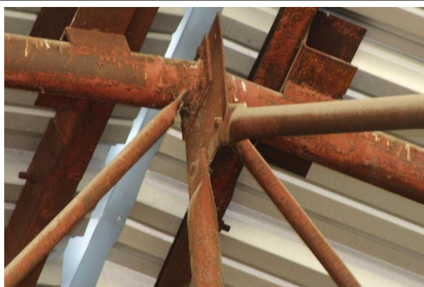
Foto 135 – pohled na ocelovou konstrukci střechy
