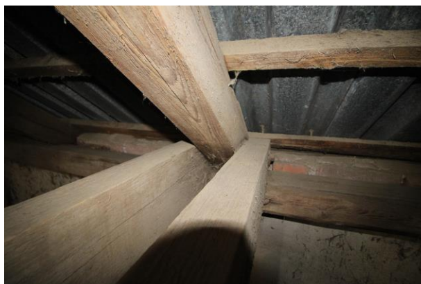
Foto 150 – pohled na dřevěnou konstrukci střechy
