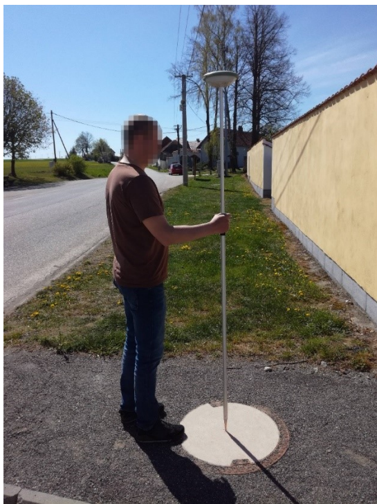
Obr. 4: Ukázka zaměření SVB technologií GNSS
