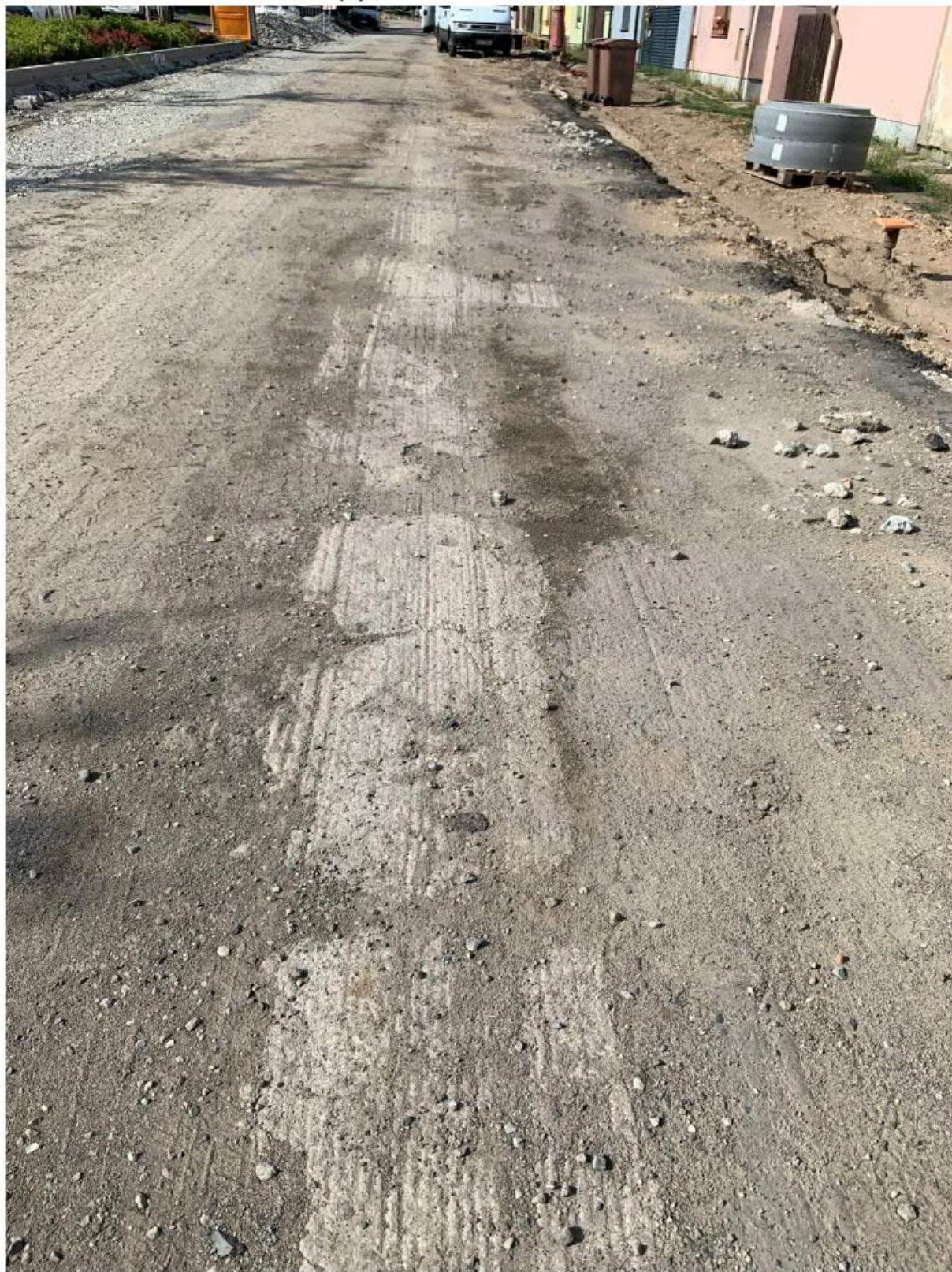
12 Fotodokumentace betonu nad plynovodem
