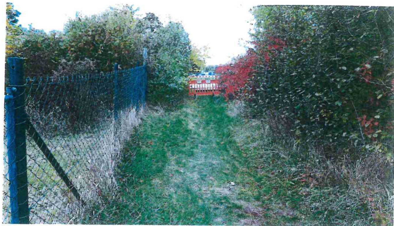
Pohled na zabezpečené místo propadu
