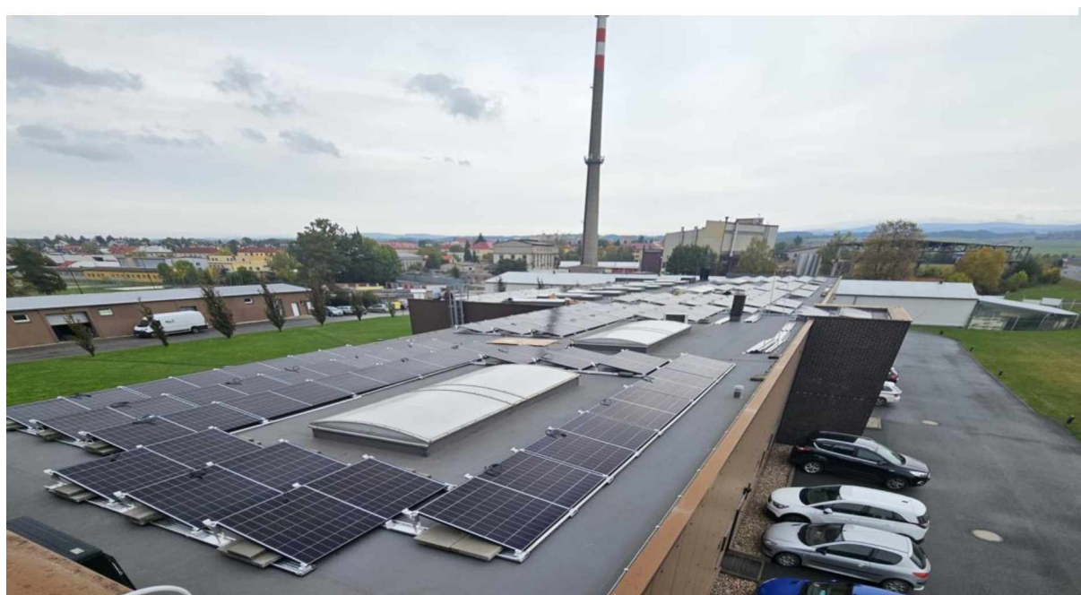
Obr. č. 5 Přítěžovaná konstrukce pro plochou střechu
