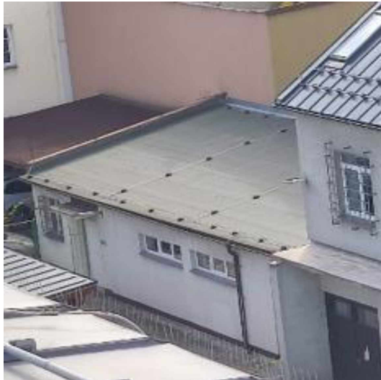
Obr. č. 14 Objekt parc. č. 956/2
