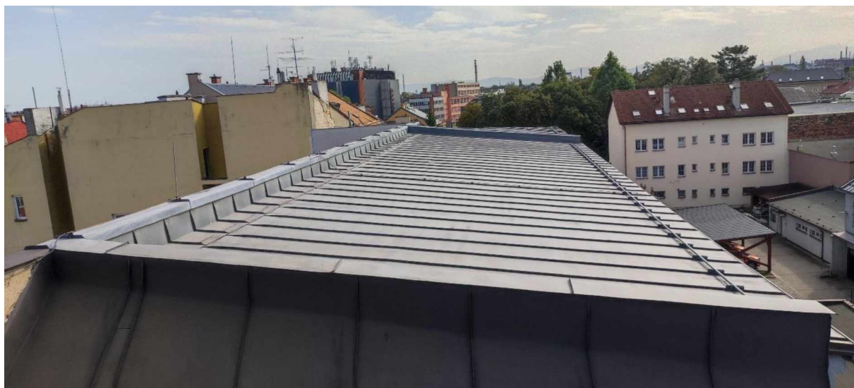
Obr. č. 4 Fotografie střechy budova B
