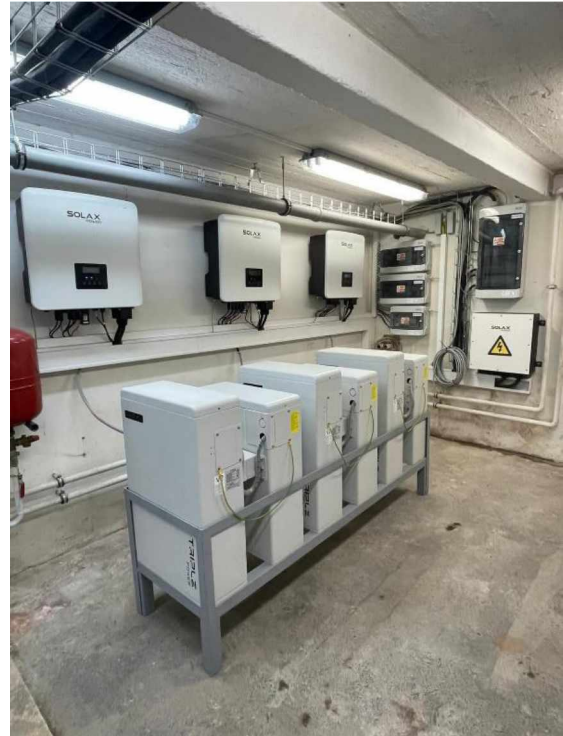
Obr. č. 8 Umístění baterií a střídačů
