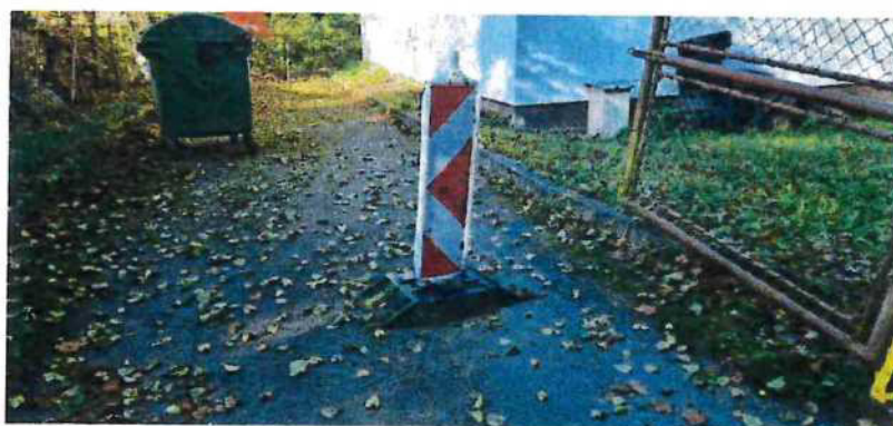
Pohled na přikryté místo propadu
