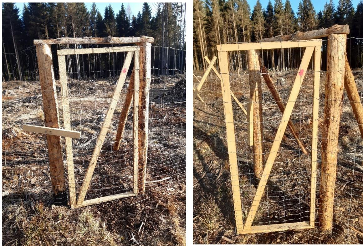
Pletivo přibité na dřevěný rám (latě, přířezy, krajinky). Zajištění proti samovolnému otevření z venkovní strany pomocí dřevěného kolíku umístěném ve středu kůlu (sloupku) prostřednictvím hřebíku (vrutu). Samovolné otevření do prostoru oplocenky je zajištěno zarážkou (kolíkem) o průměru min. 7 cm a délce min. 50 cm, jež je zatlučen v rostlé zemi min. 40 cm.
