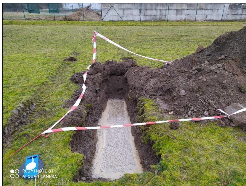
Obr. 6 Vsakovací zkouška prováděná v kopané sondě KS-6
