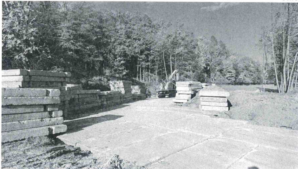
Stav na lokalitě během KD č. 3, vrt KL 148 Ženklava, zbudovaná panelová komunikace, realizace centrální plochy
