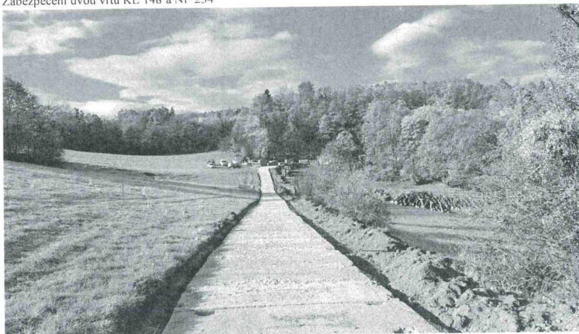
Stav na lokalitě během KD č. 3, vrt KL 148 Ženklava, zbudovaná panelová komunikace, bypass na centrální plochu
