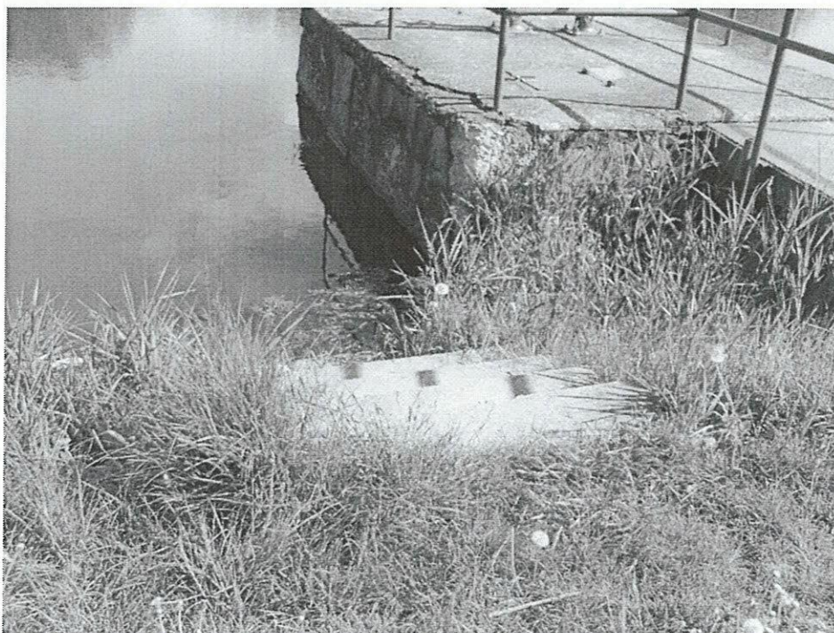
Schodiště vedle vypouštěcího a odběrného objektu
