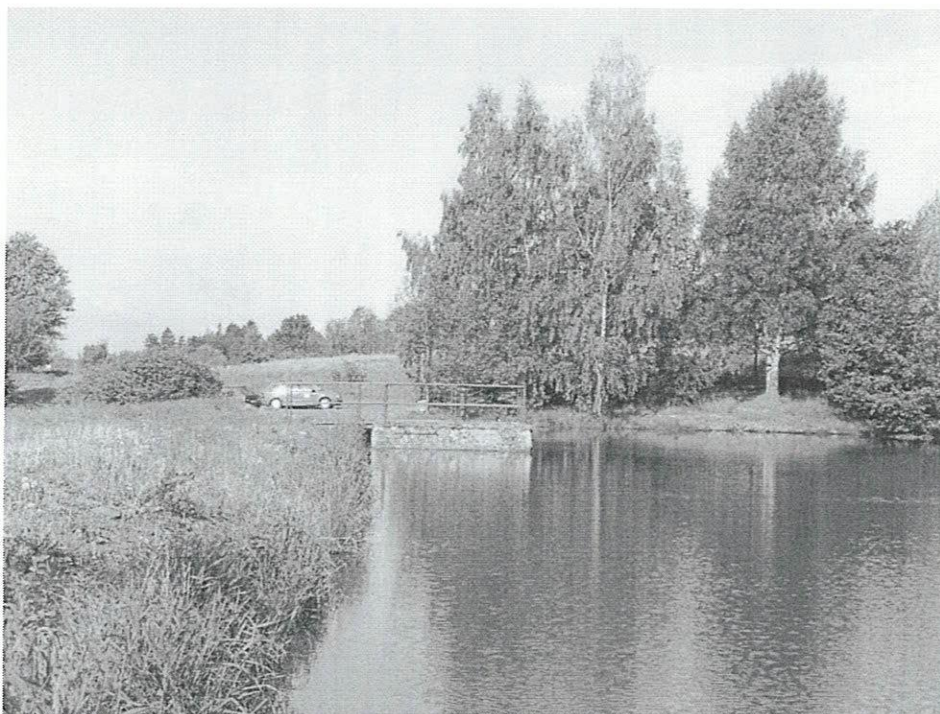
Pohled na hráz s vypouštěcím a odběrným objektem
