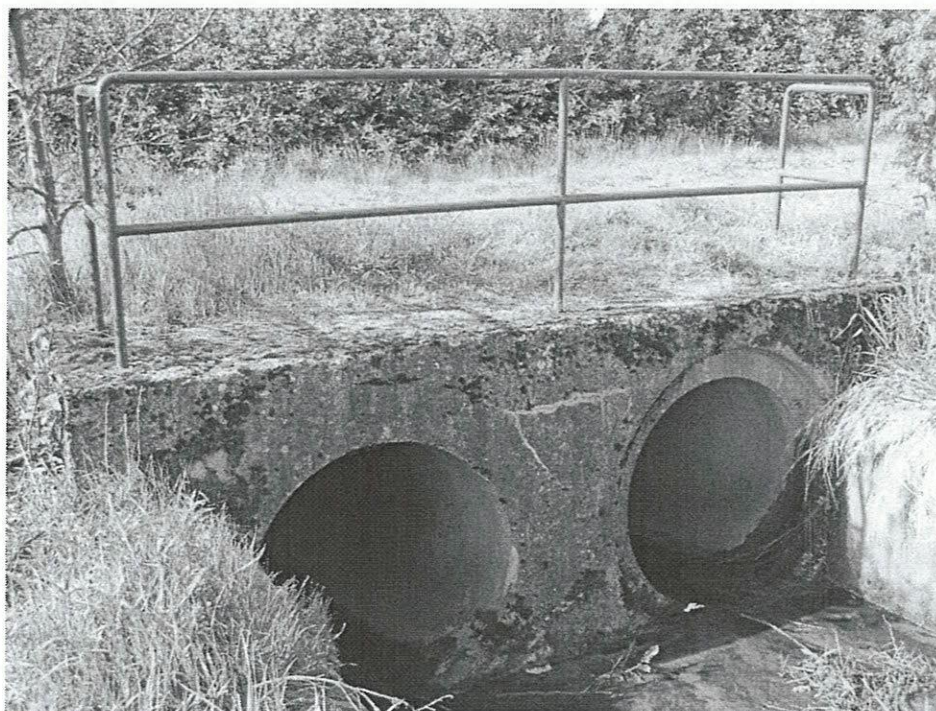
Vtok do zatrubněné části odpadu od bezpečnostního přelivu
